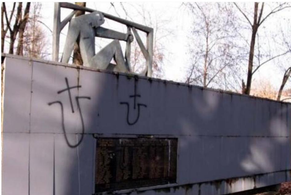
Slika 32 - "Spomenik palim borcima i žrtvama fašističkog terora" prije obnove, 2016. (izvor: https://www.antifasisticki-vjesnik.org/hr/biblioteka/3/Pocela_sanacija_devastiranog_spomenika_u_Dugoj_Resi/78/ )
