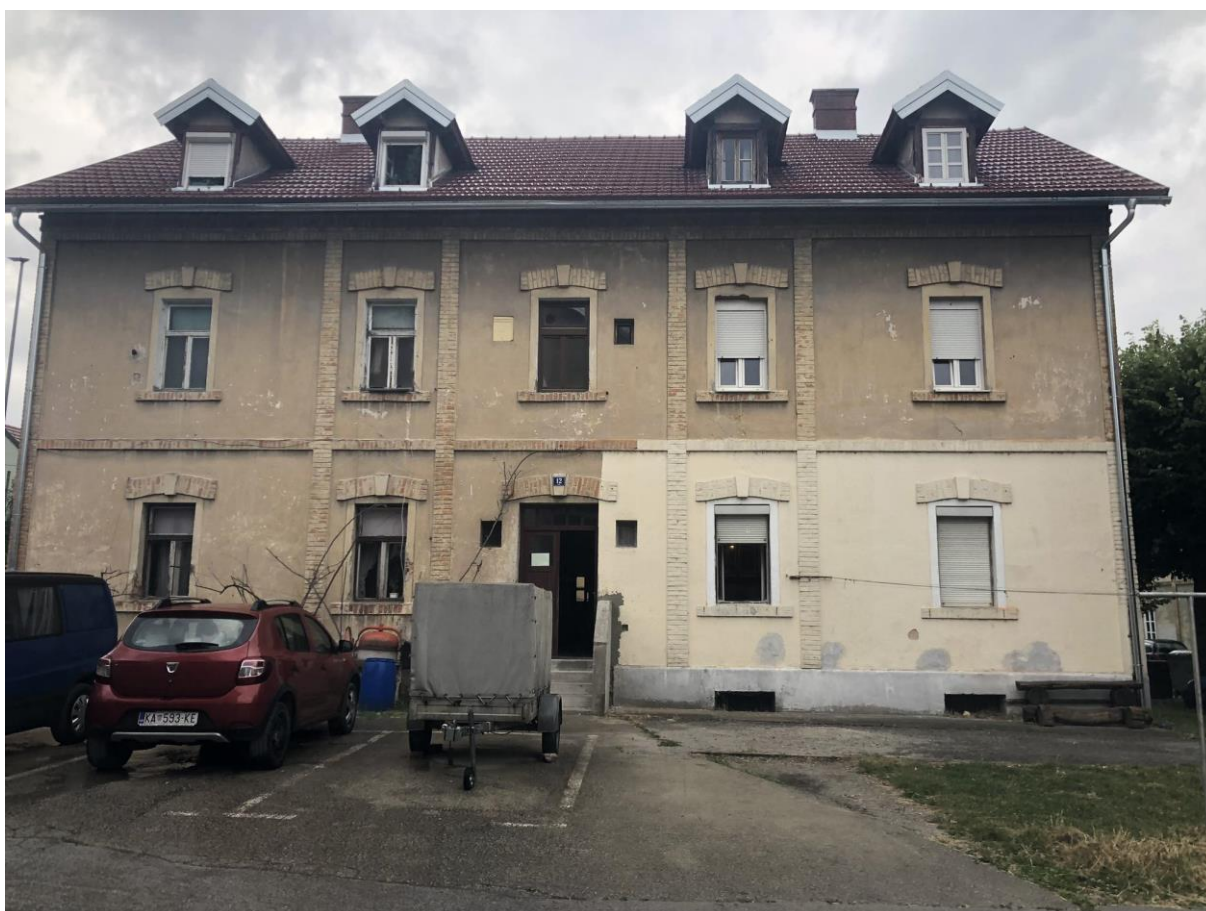
Slika 40 - Višestambena zgrada u naselju Kasar, svibanj 2023. (snimila: Marija Jurić, 2023.)
