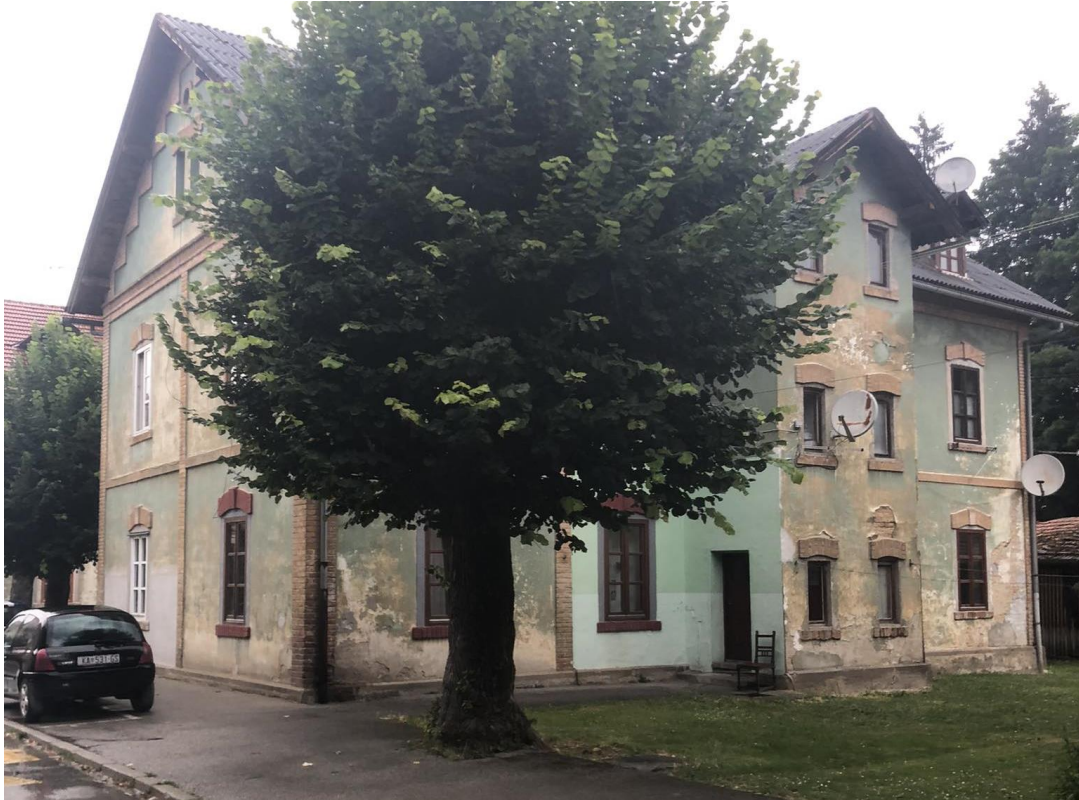
Slika 41 - Višestambena zgrada u naselju Kasar, svibanj 2023. (snimila: Marija Jurić, 2023.)
