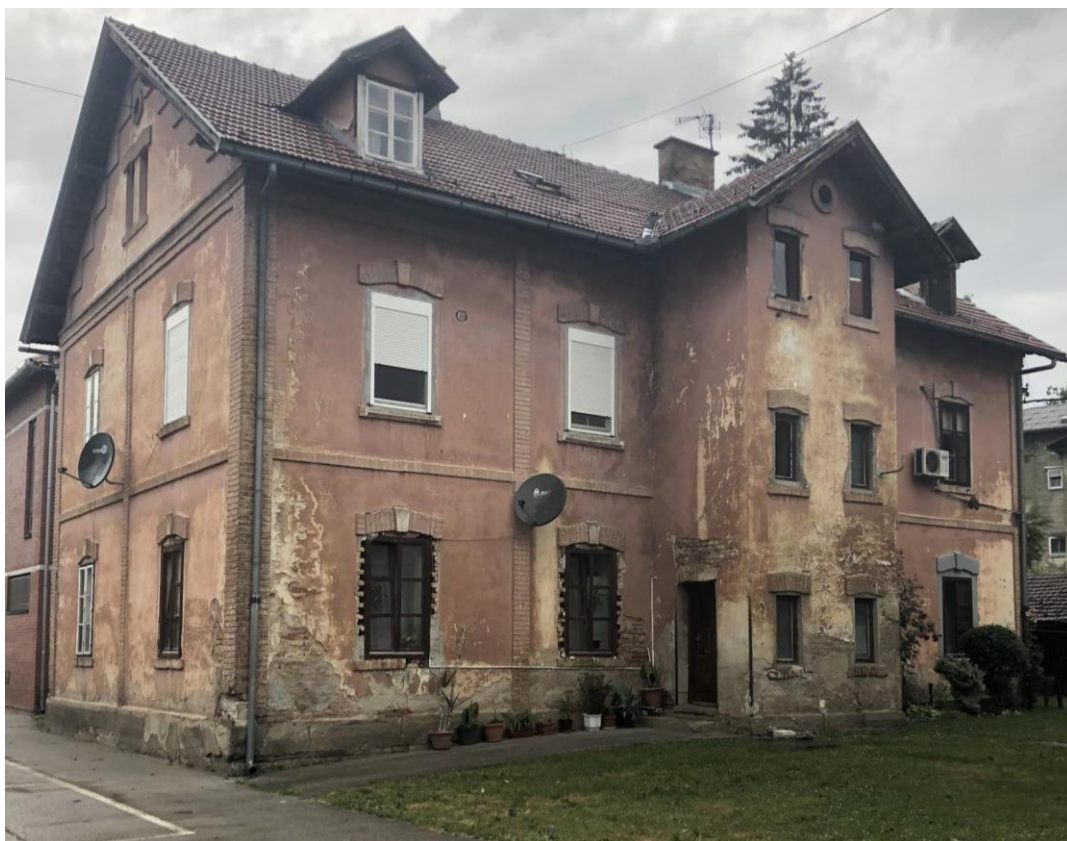
Slika 43 - Višestambena zgrada u naselju Kasar, svibanj 2023. (snimila: Marija Jurić, 2023.)
