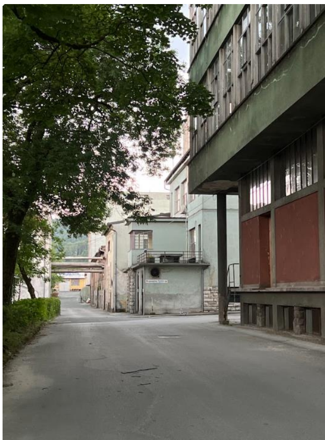
Slika 20 – Nastavak ceste unutar kompleksa tvornice, s desne strane hala „VIS PROMOTEX d.o.o.“, svibanj 2023. (snimila: Marija Jurić, 2023.)
