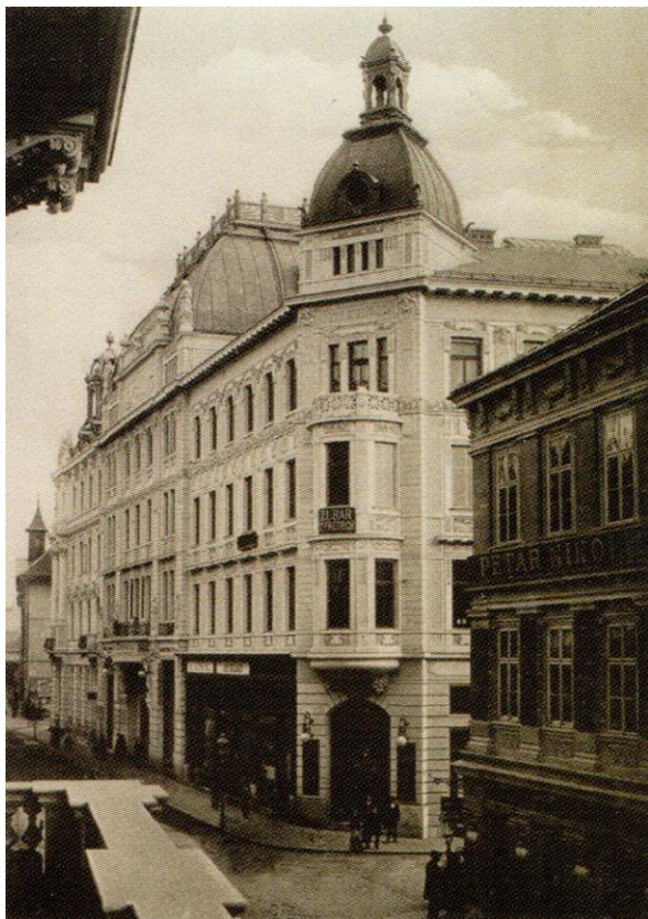
Fellner & Helmer/Josip Vancaš, Palast der ersten kroatischen Sparkasse , 1899, Ilica Str. 5/Margaretska Str. 1-3/Bogovićeve Str. 6, Zagreb
