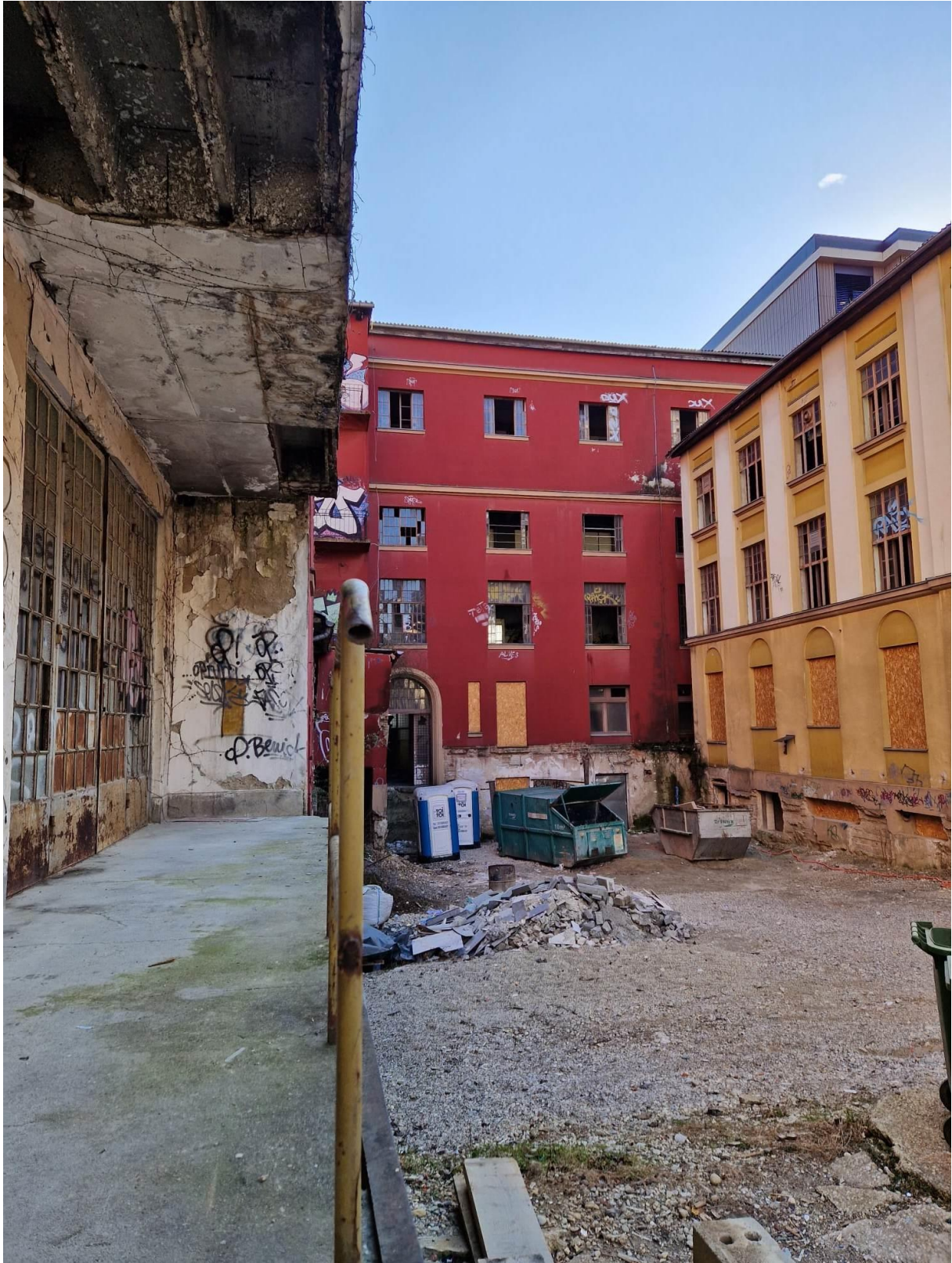
Fotografija 15: Dvorišna strana tvornice 'Nada Dimić', Izvor: Autor
