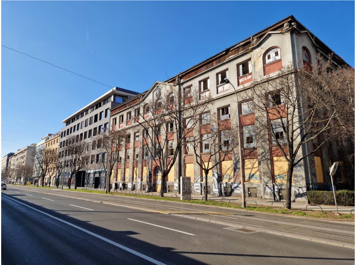
Fotografija 18: Novoizgrađeni stambeni kompleks 'Park kneževa' i bivša tvornica 'Nada Dimić' – pogled s Branimirove ulice, Izvor: Autor
