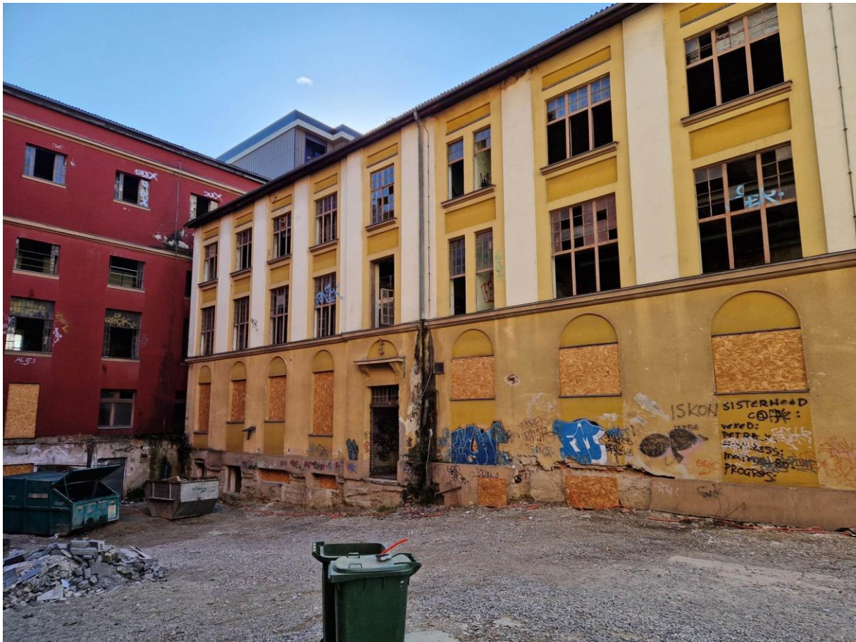
Fotografija 14: Dvorišna strana tvornice 'Nada Dimić', Izvor: Autor
