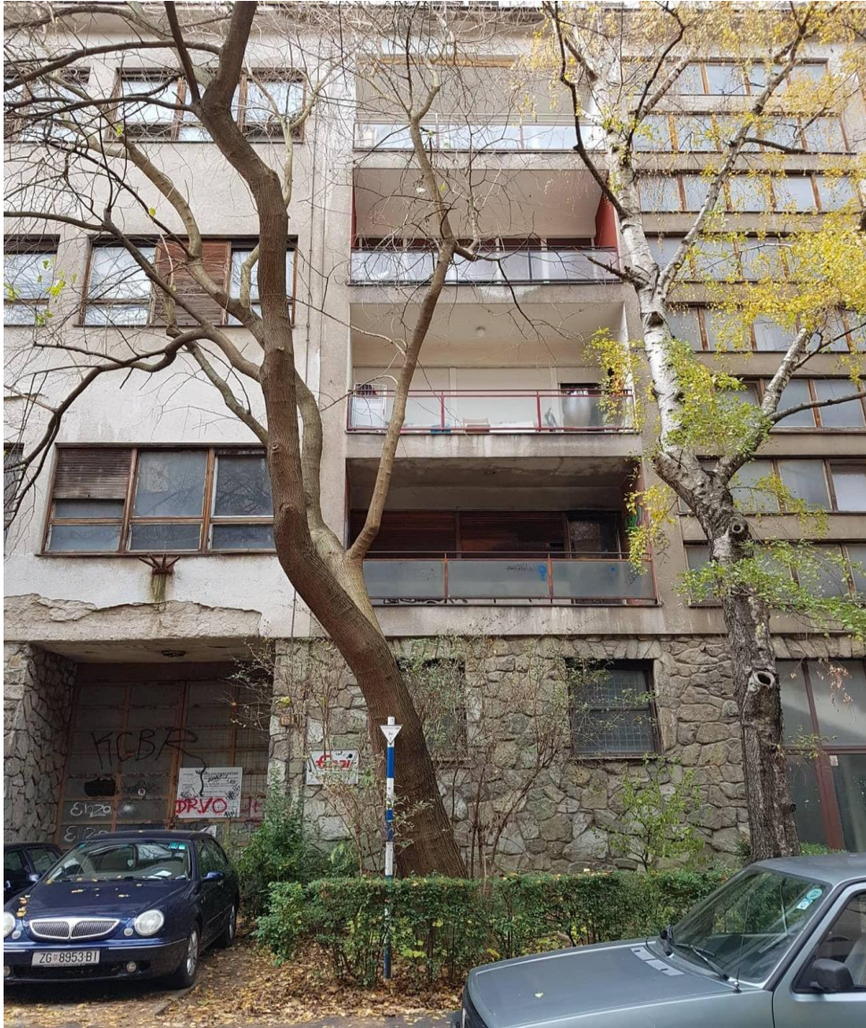
Fotografija 10: Zgrada tvornice u Erdodyevoj ulici naslanja se na stambenu zgradu, Izvor: Autor
