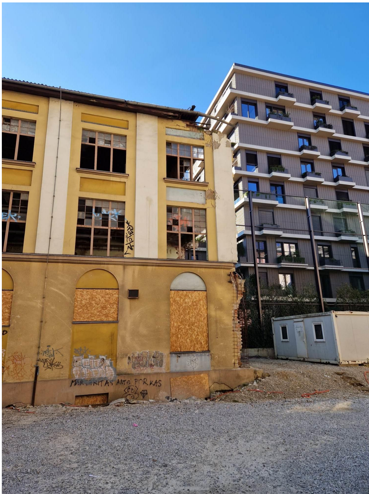
Fotografija 16: Dvorišna strana tvornice 'Nada Dimić', Izvor: Autor
