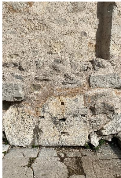
Slika 26. Tambur stupa u temelju rotonde Sv. Donata. Foto: Hana Buntak
