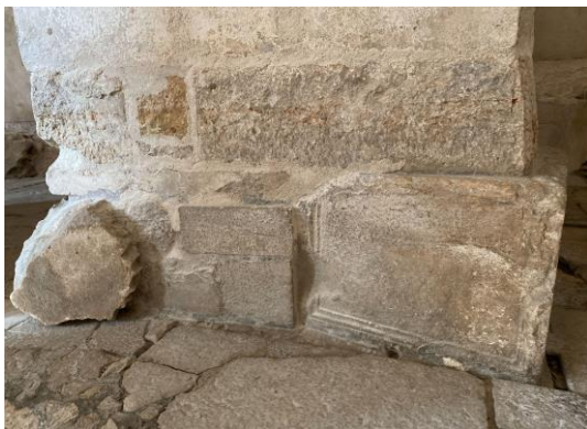
Slika 49. Kanelirani stup i dio stele u temelju petog pilona rotunde Sv. Donata. Foto: Hana Buntak
