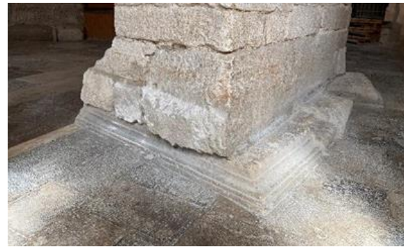
Slika 44. Baza antičkog žrtvenika u temelju trećeg pilona rotunde Sv. Donata. Foto: Hana Buntak
