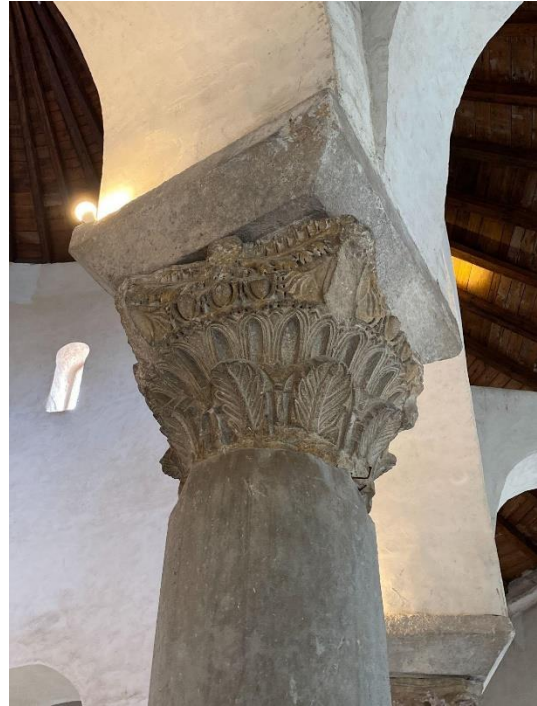
Slika 61. Preklesani kompozitni kapitel desnog stupa pred svetištem galerije rotunde Sv. Donata. Foto: Hana Buntak
