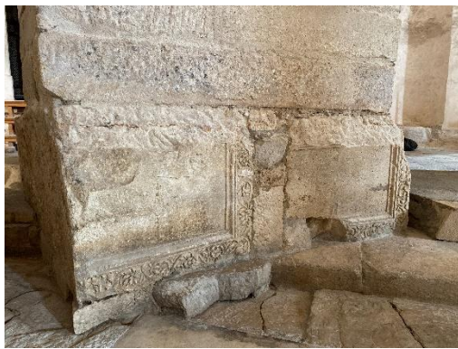
Slika 41. Postolja za skulpture u temelju drugog pilona rotunde Sv. Donata. Foto: Hana Buntak
