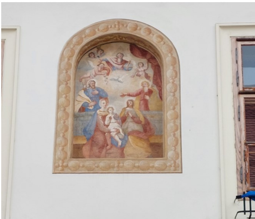
Slika 24. Oslík na Pročelju Ulice Tita Brezovačkog 1
