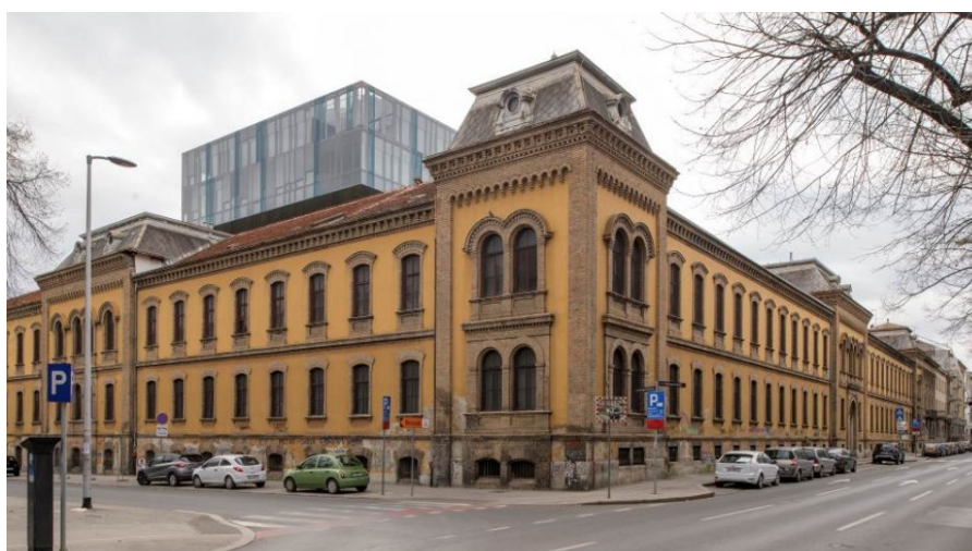
Slika 12.: Pogled na ulična pročelja sjevernog i istočnog krila
