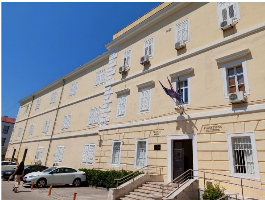
Slika 16. Primjer prilagođenog ulaza u obliku rampe u Državnom arhivu u Zadru (DAZD, 2022)
