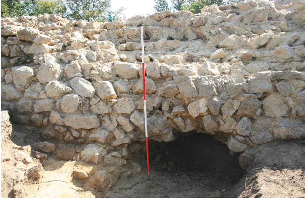
Slika 35. Urušeni dio zapadnog djela zida koji je nastao pod utjecajem erozije (fotodokumentacija Instituta za arheologiju)
