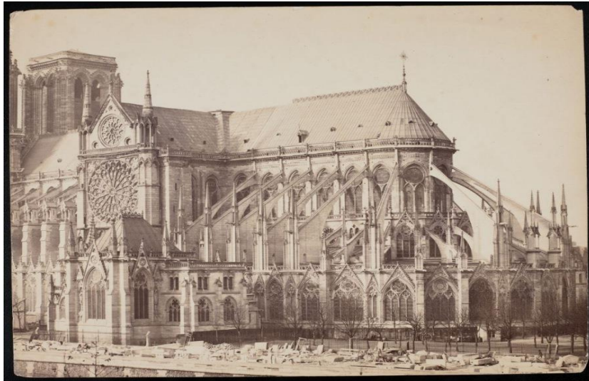
Slika 20. Prikaz radova na apside. Prozori i kontrafori su restaurirani.
