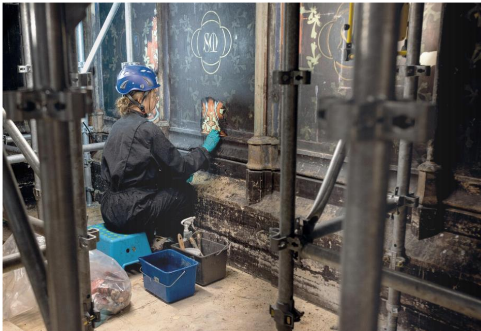
Slika 59. Čišćenje kapela koje su prekrivene crnom prljavštinom
