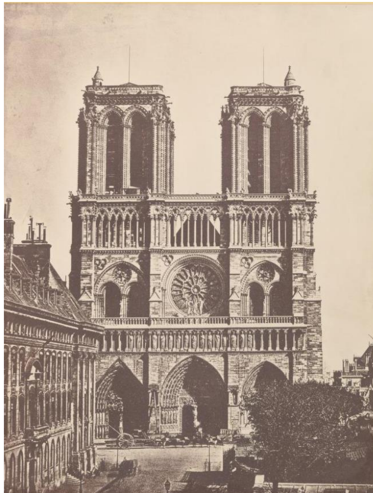
Slika 32. Pročelje katedrale, nedostaju kipovi i toranj križišta
