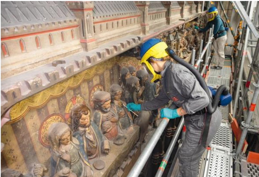
Slika 62. Čišćenje oltarne ograde
