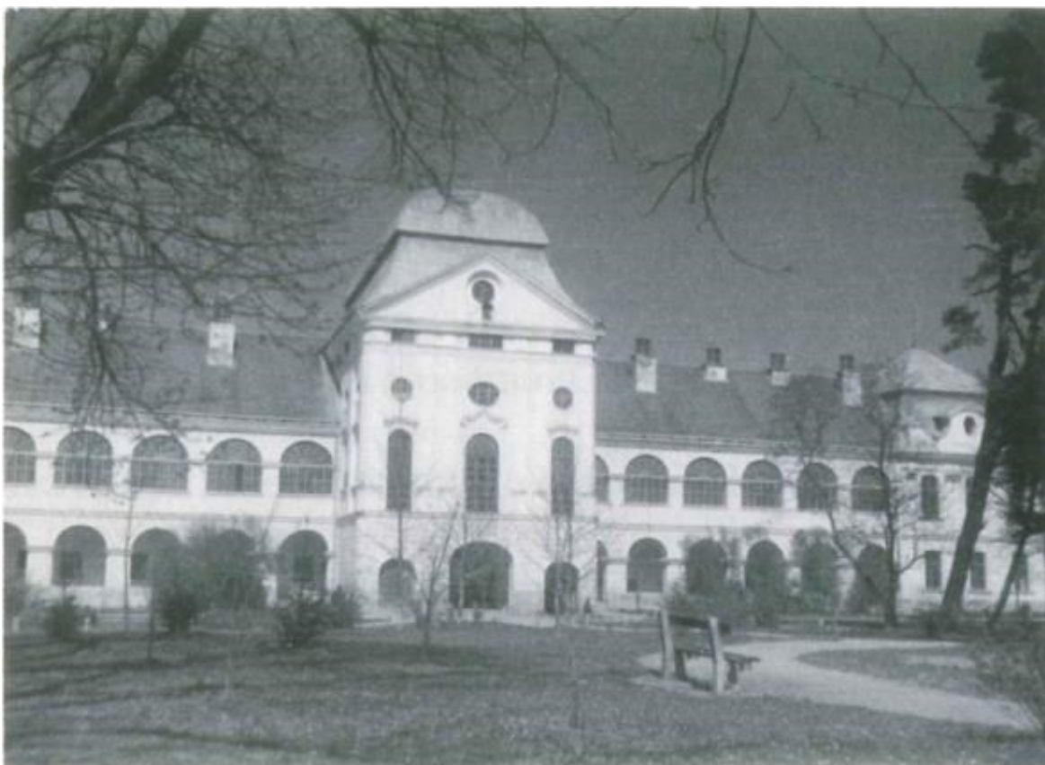
Slika 10: Južno pročelje dvorca nakon obnove 1950-ih godina
