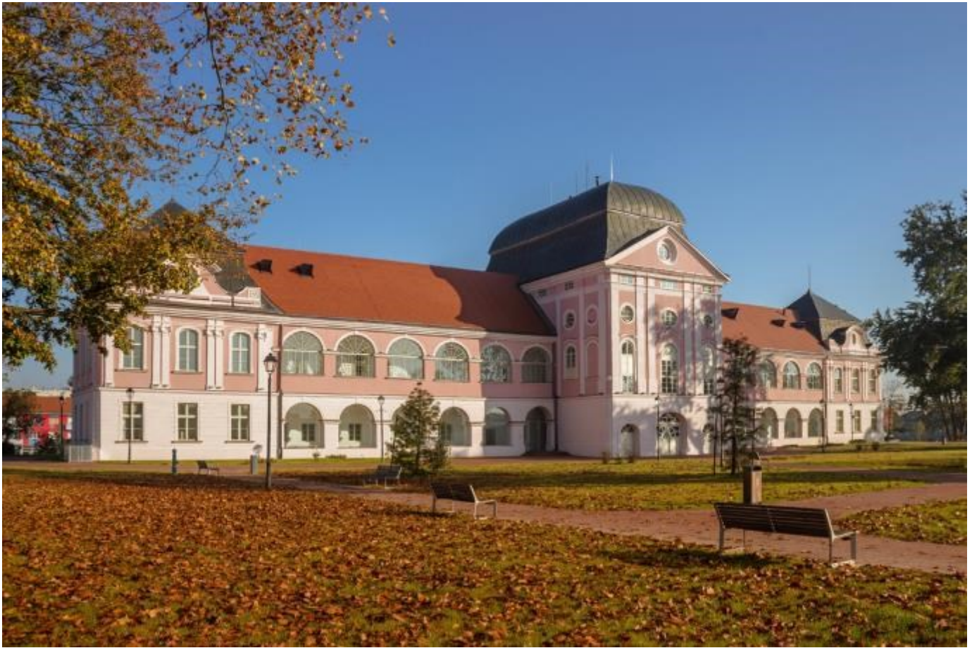
Slika 31: Južno pročelje dvorca Pejačević u Virovitici nakon obnove
