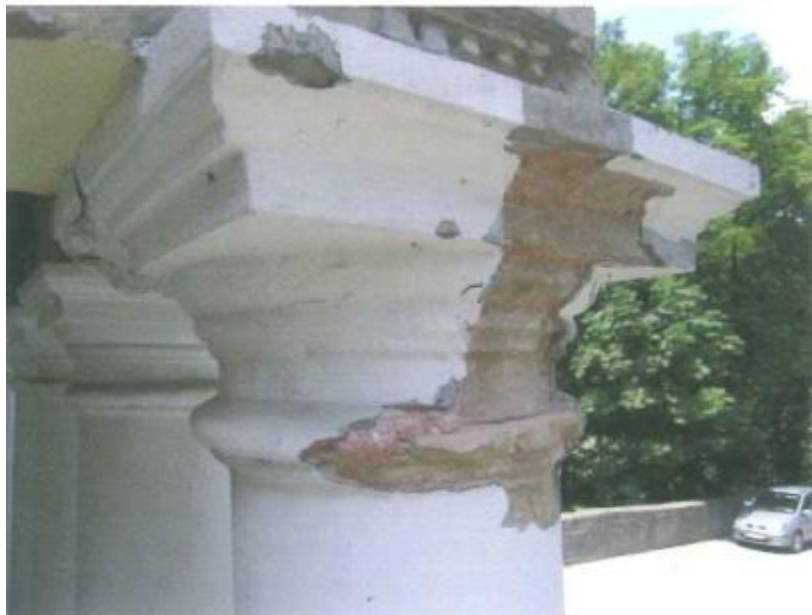
Slika 12: Kapitel stupa na zapadnoj strani altane, prikaz slojeva od crvenkastog „kamenog brašna“ preko cementne žbuke i završnih bijelo bojanih slojeva
