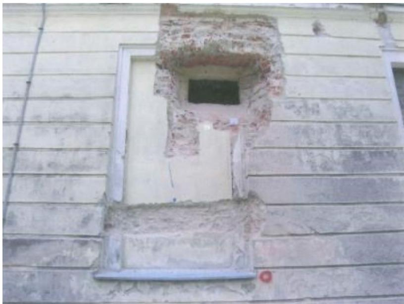
Slika 11: Sonda na zapadnom krilu sjevernog pročelja, otkriveni zazidani prozorski okvir
