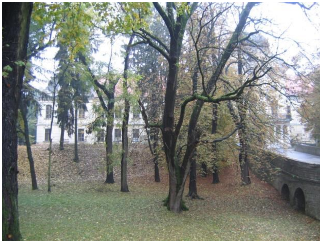
Slika 22: Pogled na istočno krilo i središnji rizalit dvorca i park prije rekonstrukcije
