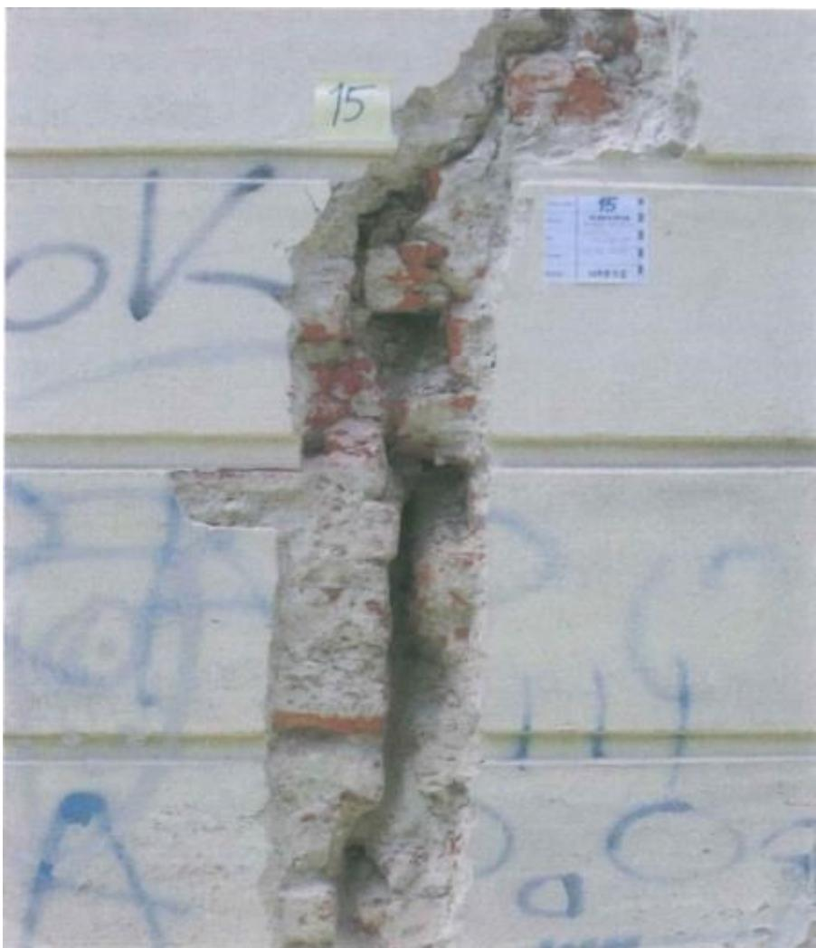
Slika 15: Reška na zapadnom pročelju dvorca, sondiranjem utvrđeno da nije nastala kao posljedica konstruktivnog slijeganja zida već u nekoj od graditeljskih intervencija
