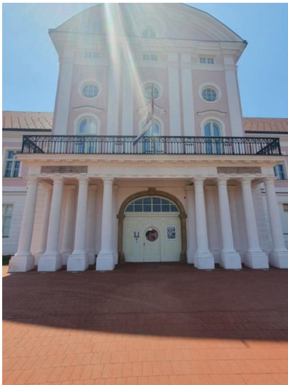
Slika 25: Središnji rizalit sjevernog pročelja nakon obnove
