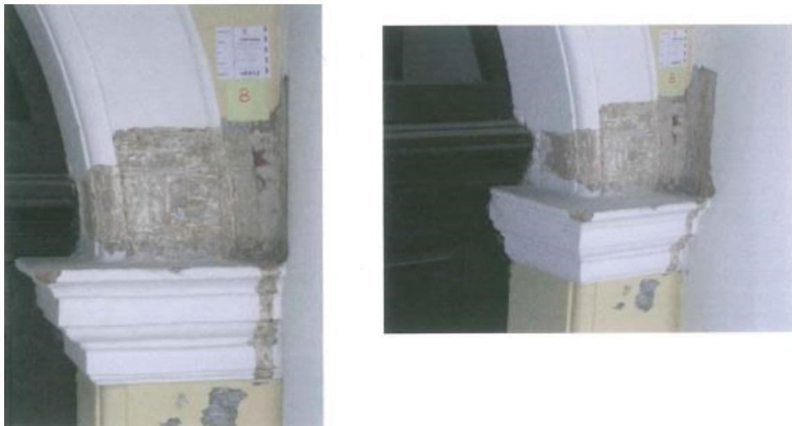
Slike 13 i 14: Sondiranje u okviru glavnog portala u altani sjevernog pročelja, prikaz izvornog kamena pješčara tretiranog vapnenim mlijekom te sloja cementne žbuke sa bojanim slojevima
