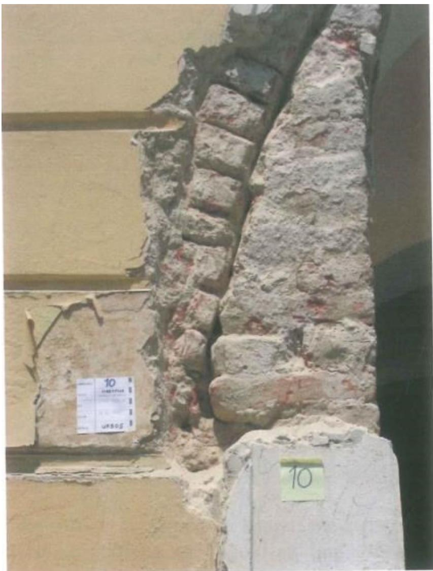
Slika 16: Segment portala južnog pročelja dvorca, sondiranjem otkrivena izvorna geometrija rasteretnog luka ispod cementno-vapnene žbuke
