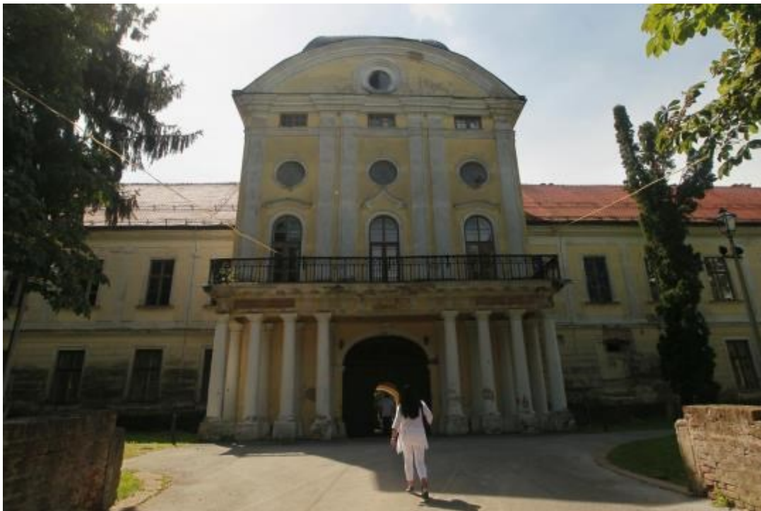
Slika 20 : Sjeverno pročelje dvorca Pejačević prije obnove,
