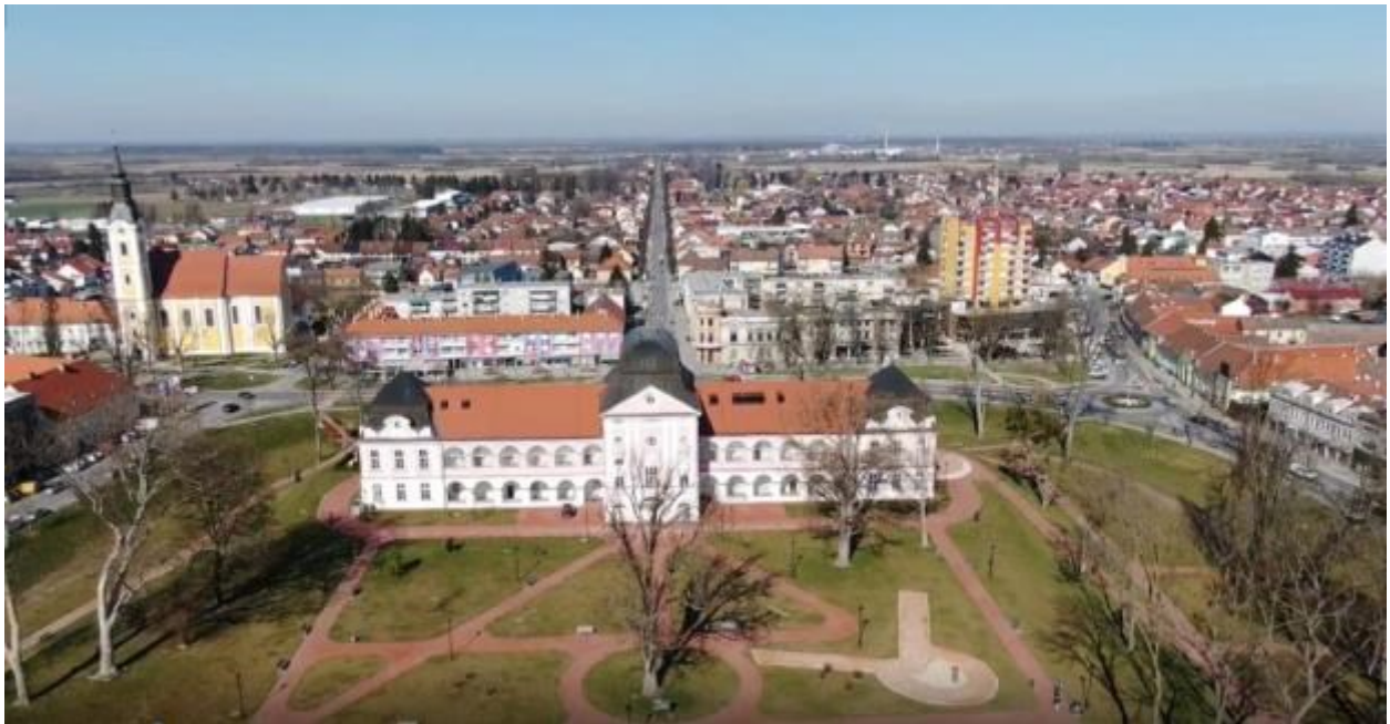
Slika 43: Pogled na južnu stranu virovitičkog dvorca i perivoja nakon rekonstrukcije
