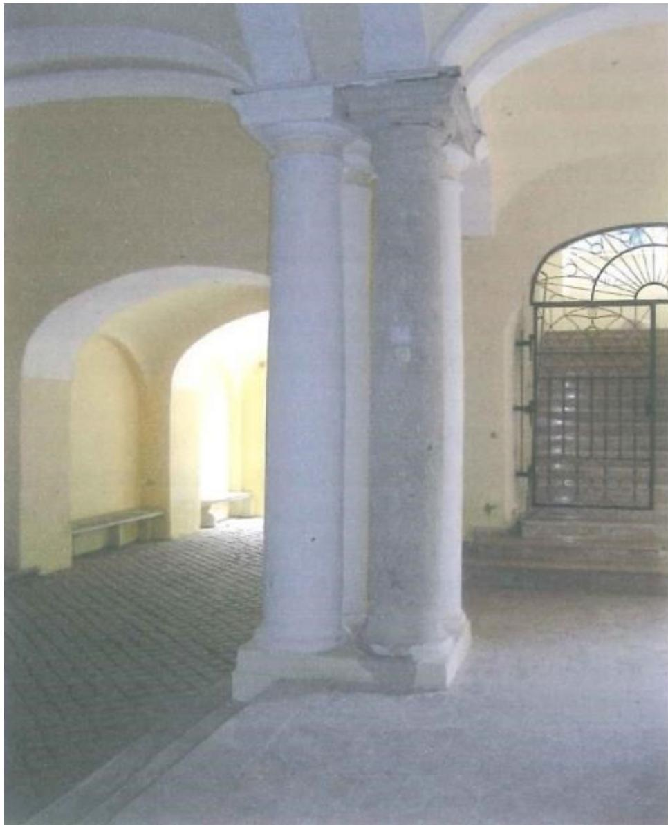
Slika 18: Kolonada stupova ulaznog hola, u cijelosti prežbukana debelim slojem cementno-vapnene žбуке kojom su negirane pojedine profilacije
