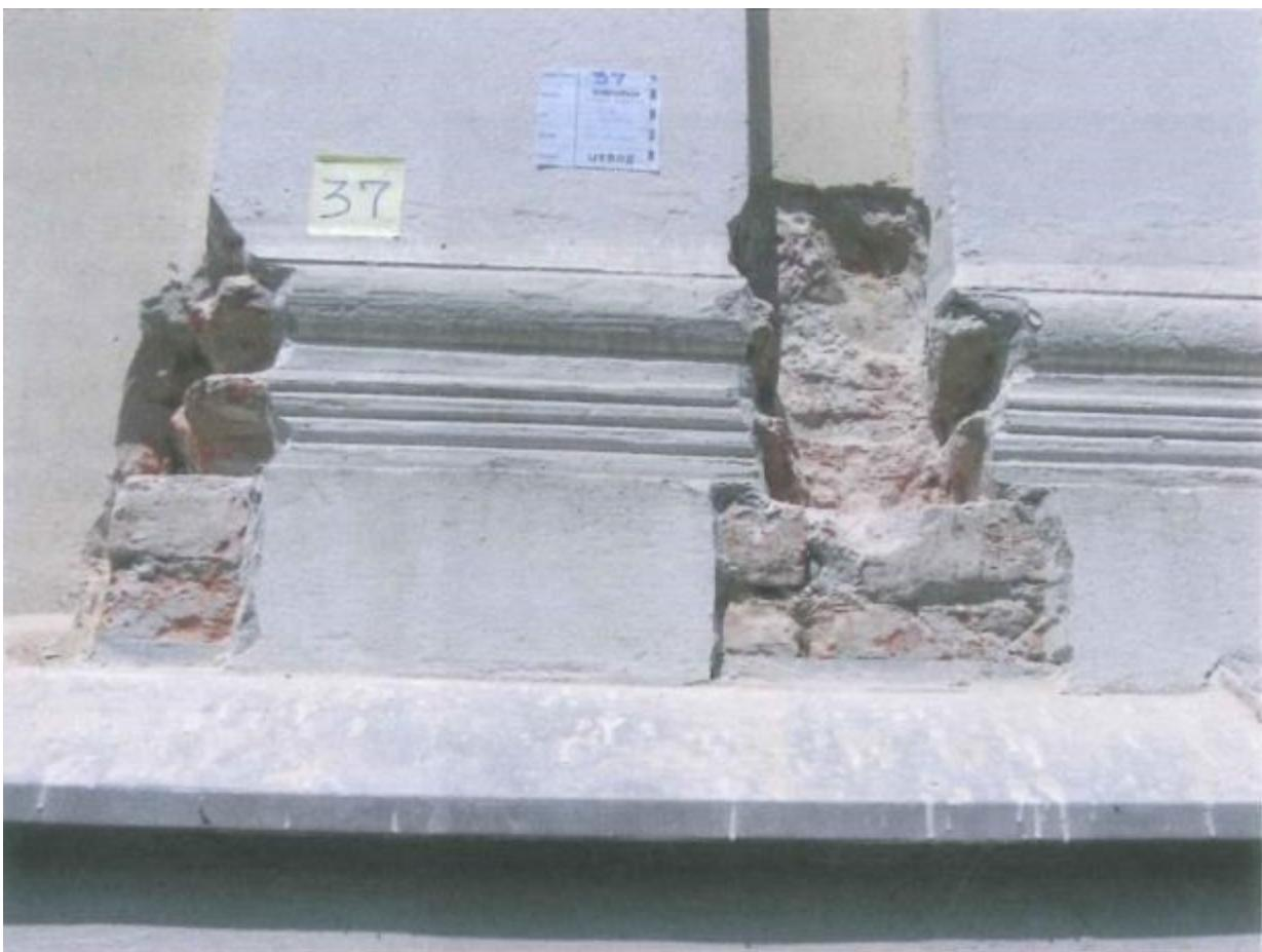
Slika 17: Sonda na južnom pročelju u podnožju katnih pilastara kojom je pronađena izvorna vapnena žbuka bojena u tri faze, od kojih je za rekonstrukciju odabrana ona prva, boje rumenog okera
