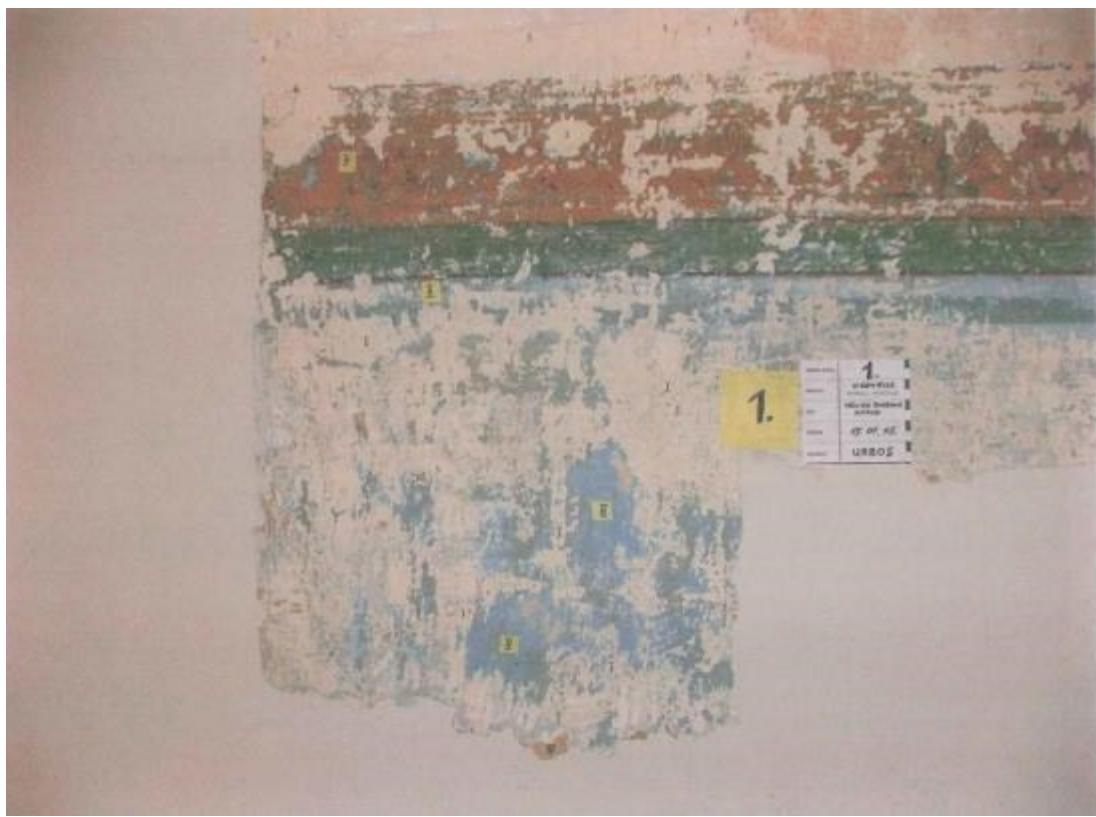
Slika 19: Sonda otvorena na zapadnom zidu velike hale u prizemlju dvorca, a u kojoj se može vidjeti stanje oslika i bojenih slojeva
