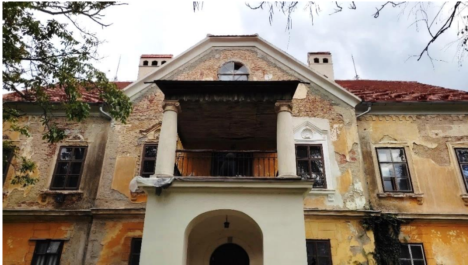
Slika 1: Detalj pročelja s altanom
