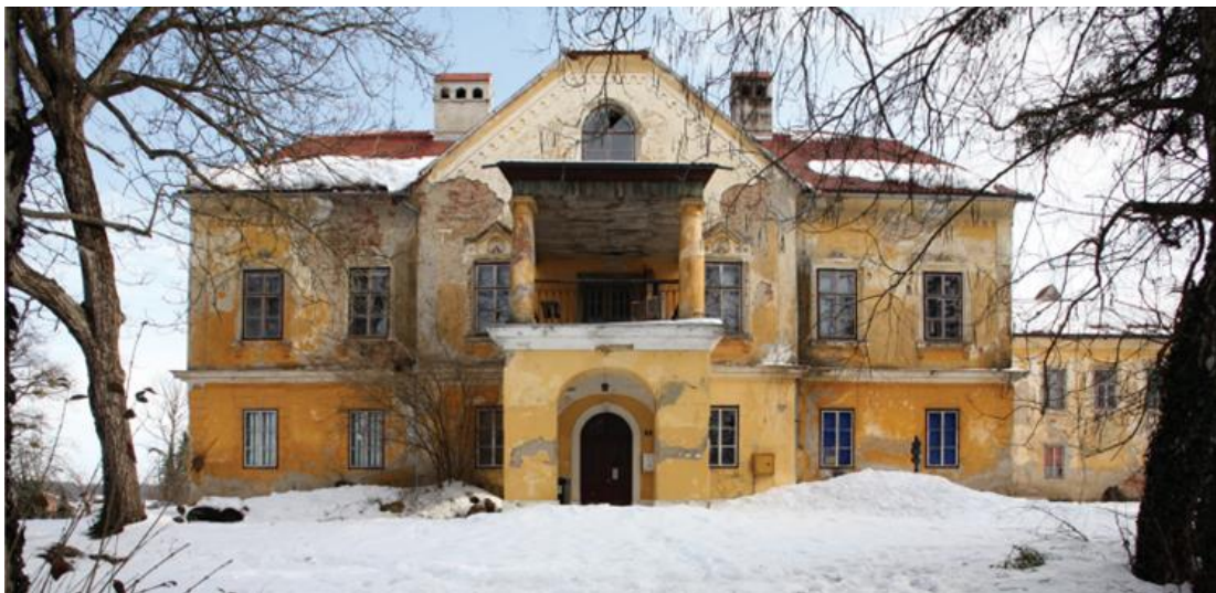
Slika 2: Pročelje glavnog krila, recentno stanje
