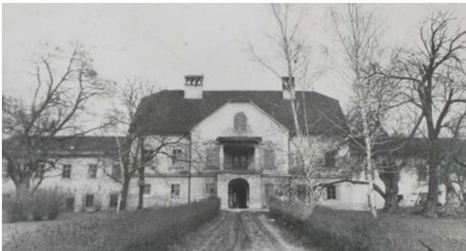
Slika 3: Pročelje glavnog krila, 1956.
