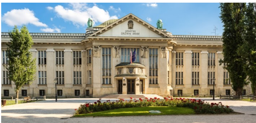
Slika 1: Matična zgrada Hrvatskoga državnog arhiva u Zagrebu
