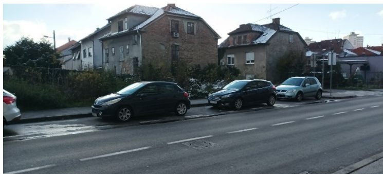
Prilog 25: Zapušteni objekti u Baštijanovoj ulici (autorska fotografija).
