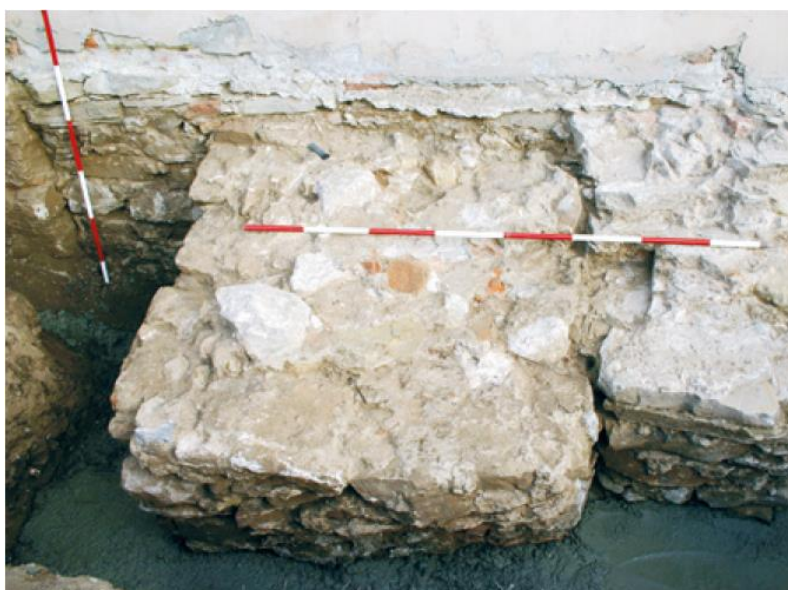
Slika 7 Crkva sv. Lovre, kontrafor južnog zida svetišta s dozidanom strukturom. Snimila 2009. B. Marciuš 336 (Marijana Korunek, Branka Marciuš, Josip Kovač, »Kapela i Trg sv. Lovre u Cirkovljanu«, u: Godišnjak Hrvatskog restauratorskog zavoda 6 (2015), str. 59)
