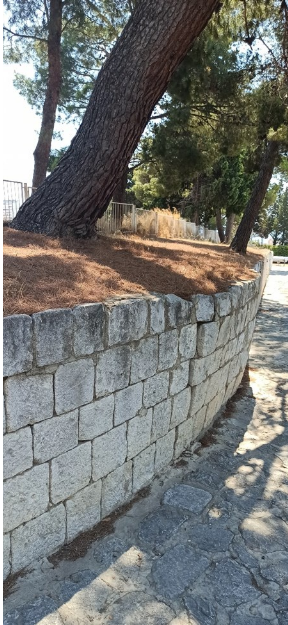
Slika 61 Alepski bor koji razara zid na tvrđavi Gripe (Foto: I. Domitrović)
