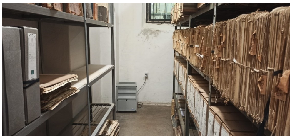
Slika 25 Odvlaživač u spremištu Arhiva u Zadru (Foto: I. Domitrović)
