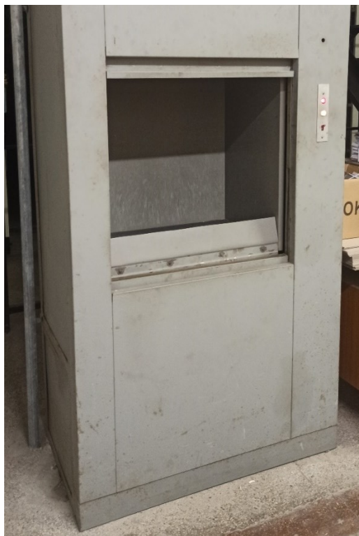
Slika 29 Lift za dostavu gradiva unutar Arhiva (Foto: I. Domitrović)
