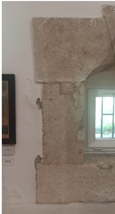
Slika 59 Prodor vlage kod prozora na sjevernom zidu tvrđave Gripe (Foto: I. Domitrović)
