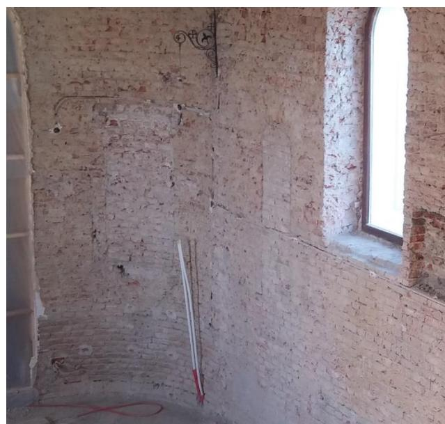
Slika 104: Zazidani ulaz u propovjedaonicu na zapadnom zidu.
