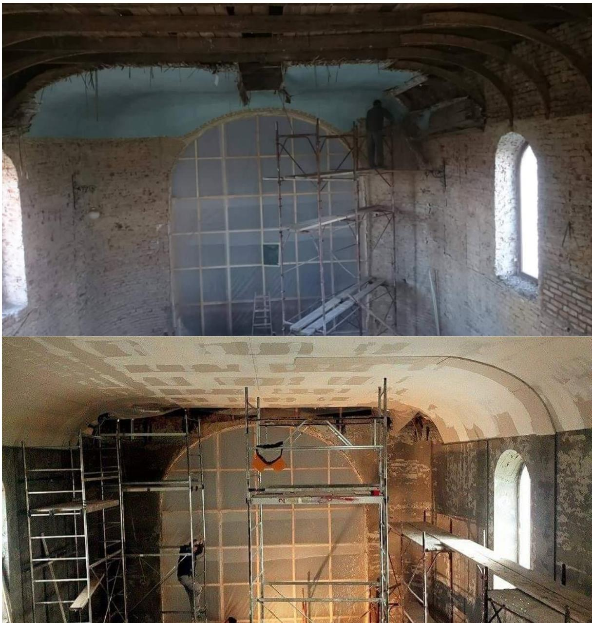
Slika 115 i 116: Uklanjanje svoda i postavljanje novog.
