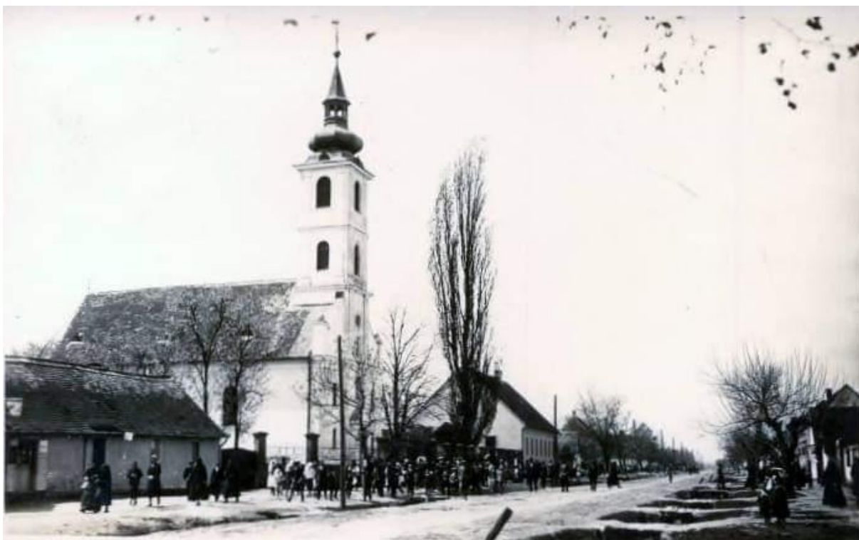
Slika 105: Garčin nakon prve rekonstrukcije fasade.
