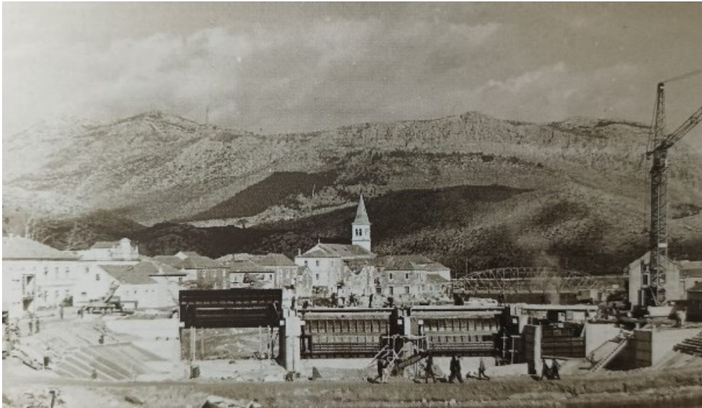
Slika 25 Izgradnja brane na Maloj Neretvi u Opuzenu, 1969.
