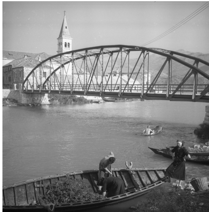
Slika 36 Željezni most na Maloj Neretvi (Stari most), 1955.
