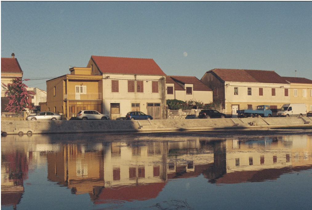
Slika 27 Obiteljske kuće u Opuzenu, 2023.
