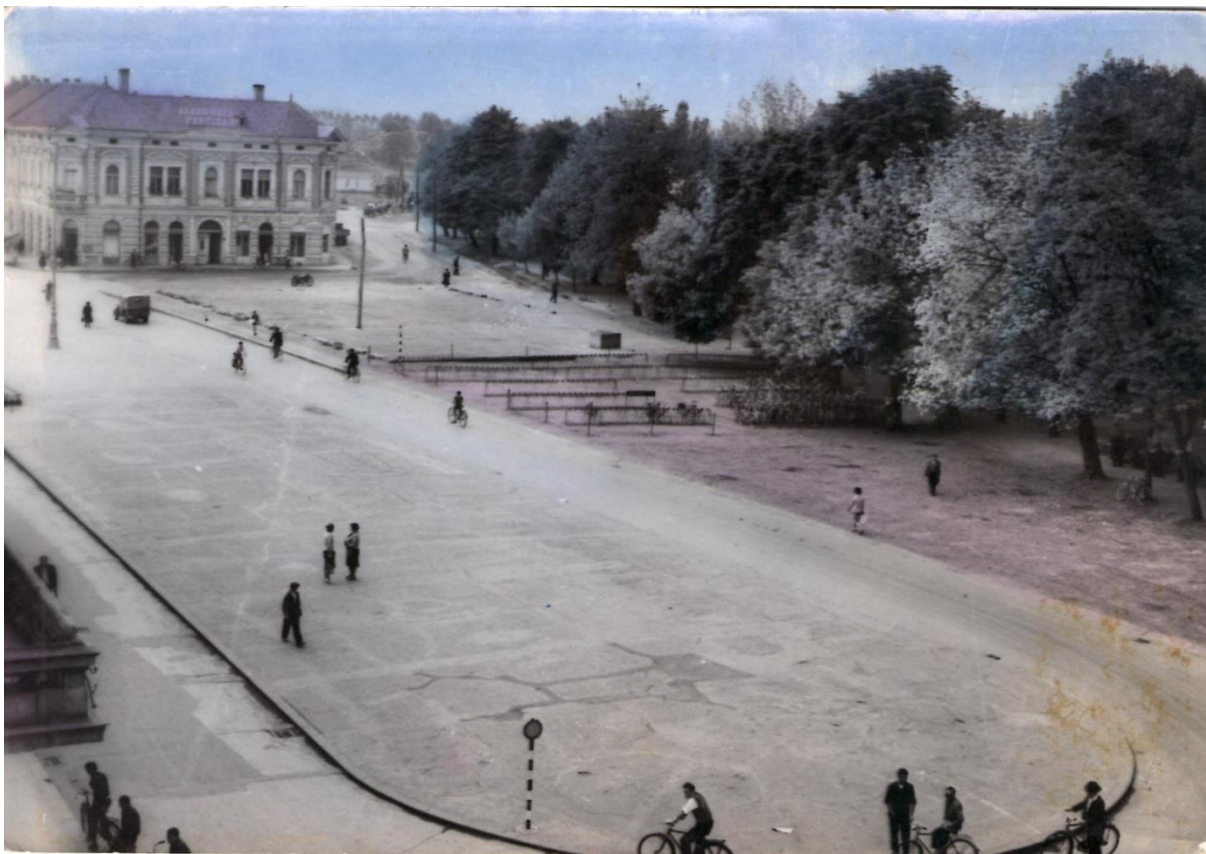
Slika 49. Izgled trga nakon rušenja Prve hrvatske štedionice 1950. godine.
