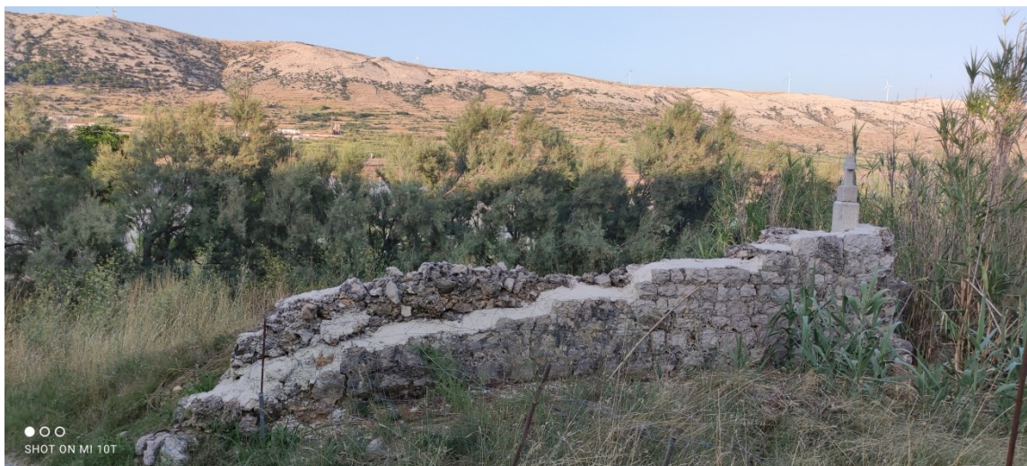
SLIKA 17. Crkva sv. Grgura, ostatci južnog zida. Foto: M. Komar.
