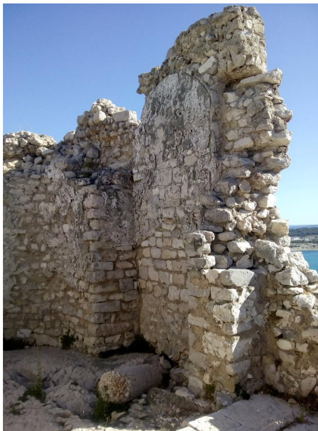
Slika 22: Pogled prema južnom zidu crkve s ostacima žbuke i vidljivim lukom . Fotografija: Đurđica Mirić
