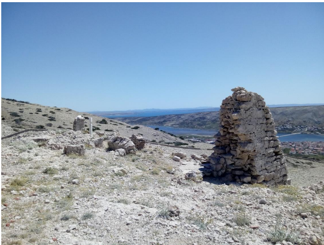
Slika 28: Ostaci potpornog zida. Fotografija: Đurđica Mirić
