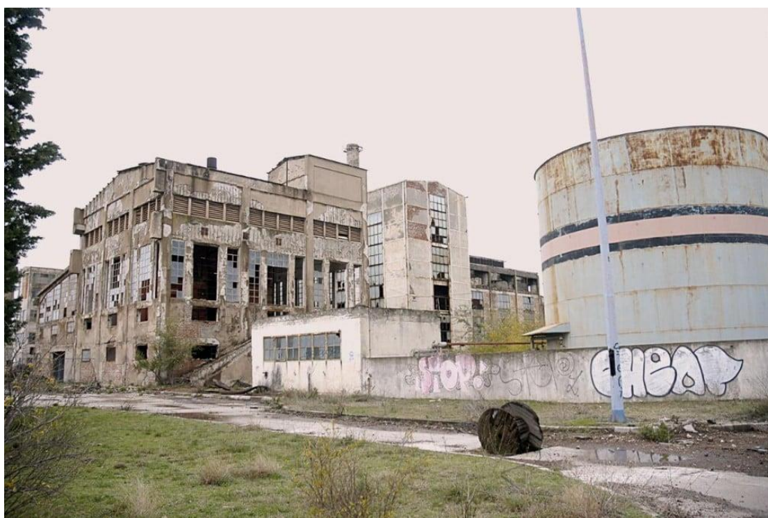
Slika 32. Napušteni prostor nekadašnje Tvornice aluminija u Lozovcu.
