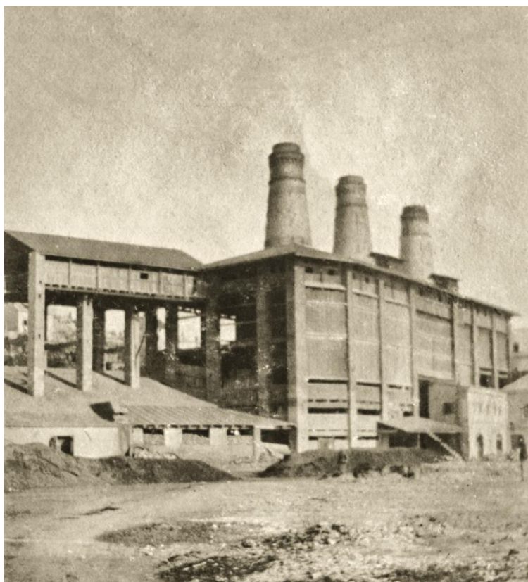
Slika 4. Grupacije peći za cement tipa Dietzsch u sklopu splitske tvornice Gilardi & Bettiza , 1920.
