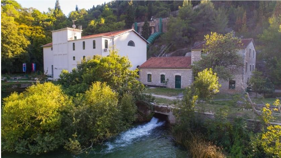
Slika 17. Hidroelektrana Jaruga II, današnje stanje (stanje nakon obnove 1937.).
