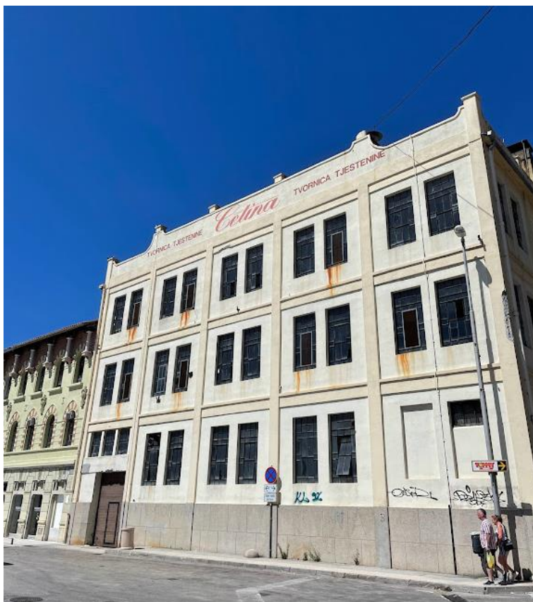
Slika 69. Zgrada nekadašnje tvornice tjestenine Cetina u Omišu, pogled na glavno pročelje 2022.
