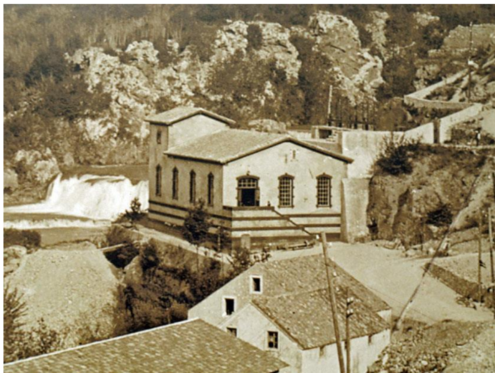
Slika 14. Hidroelektrana Krka (Jaruga I) na Skradinskome Buku, početak 20. stoljeća.
