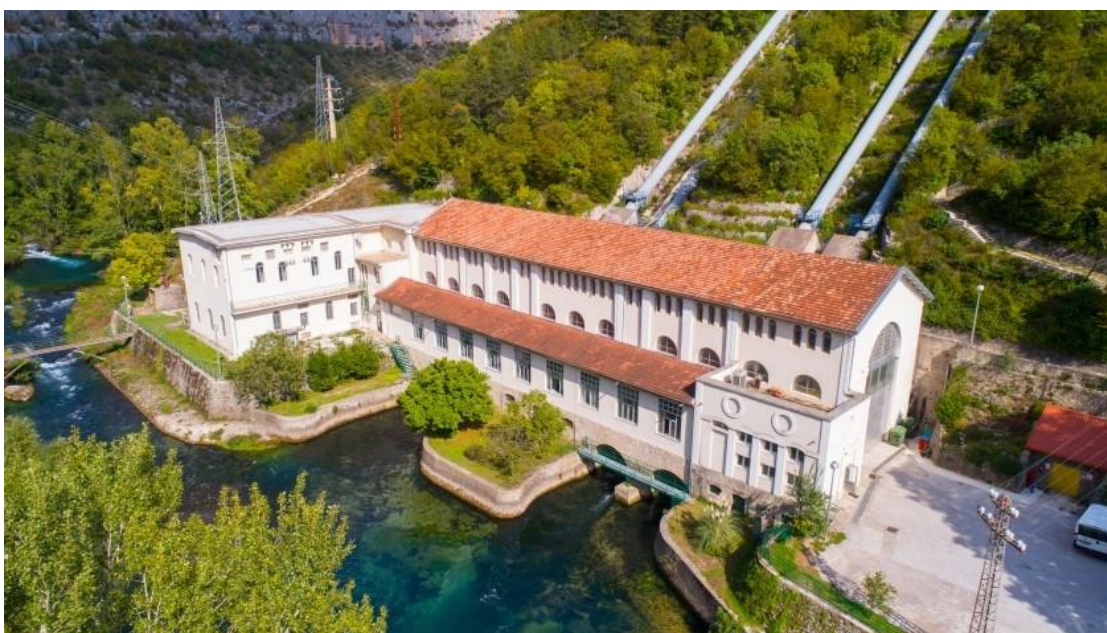
Slika 20. Hidroelektrana Manojlovac (Miljacka), današnje stanje.
