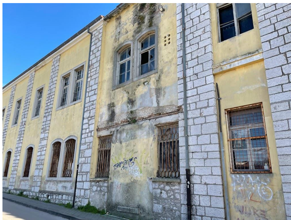
Slika 48. Nekadašnja Tvornica duhana u Zadru, detalj vanjskoga pročelja krila, 2022.
