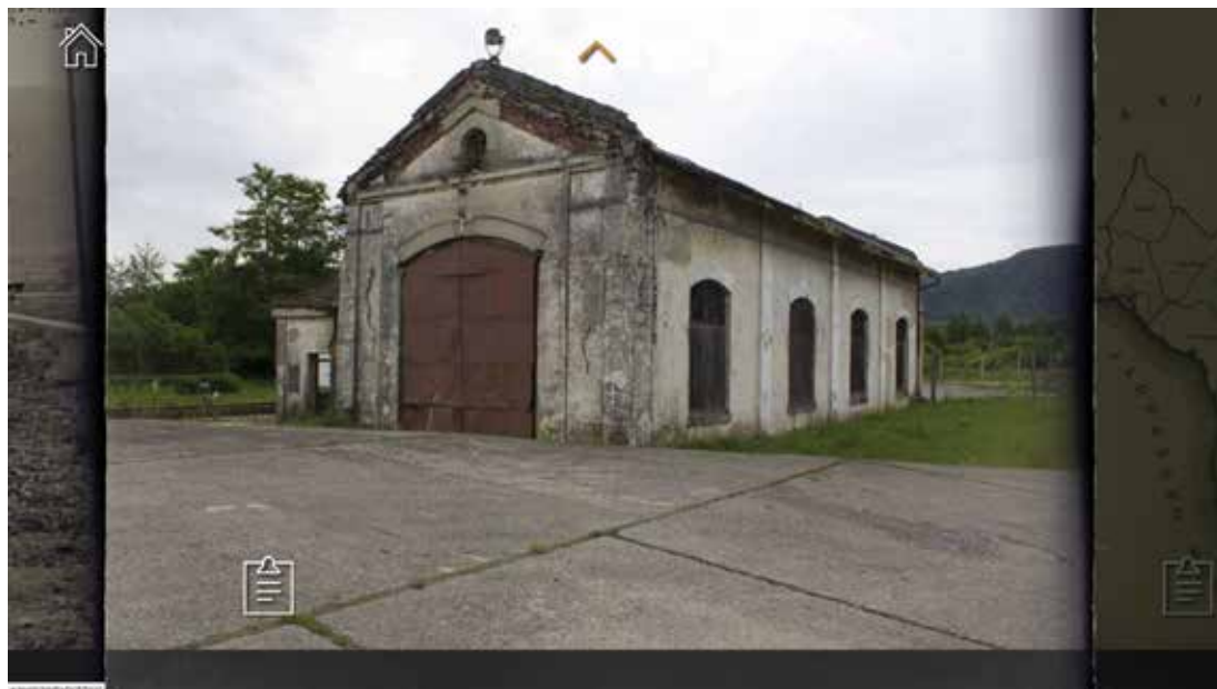
Slika 2. Lokomotivski depo (nekadašnja ložionica) u kolodvoru Plaški, lipanj 2014.
