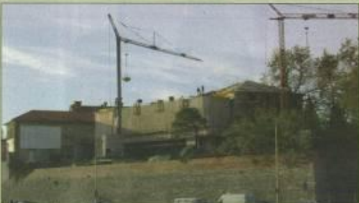
Tako trenutno izgleda gradnja
