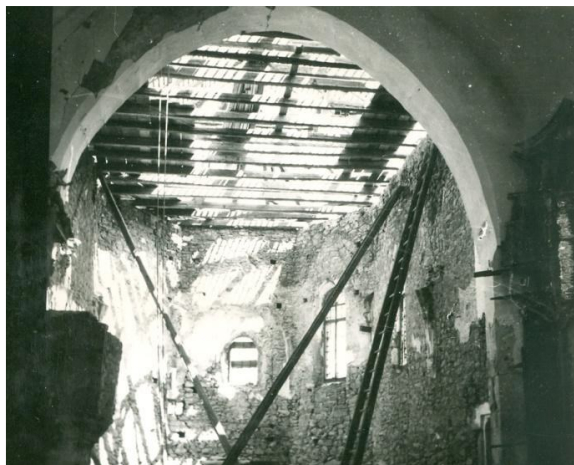
Slika 16 Očura, kapela sv. Jakova, pogled na svetište sa novim stropnim gredama, Greta Jurišić, 1952.
