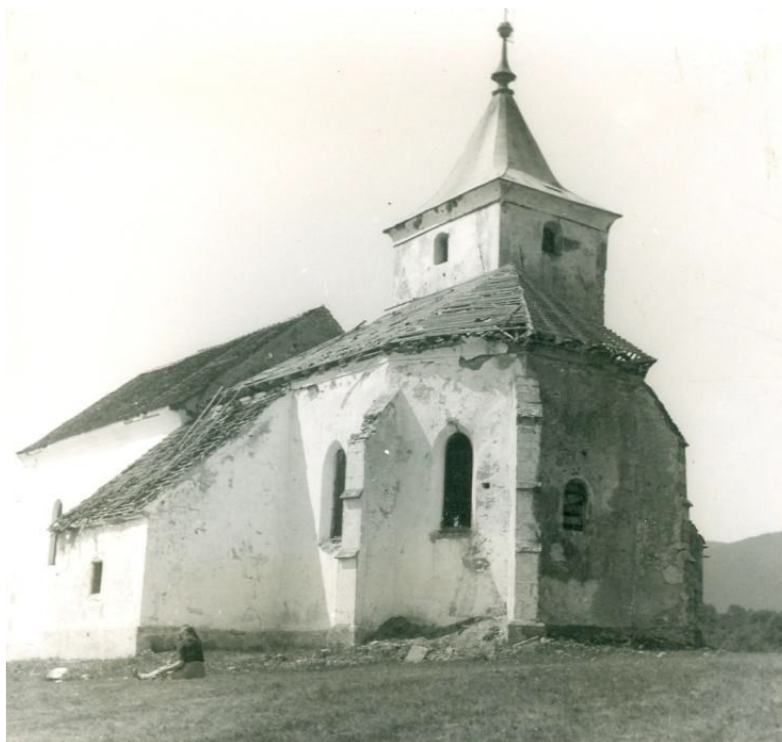
Slika 12 Očura, kapela sv. Jakova, pogled na oštećeno svetište, 1945.
