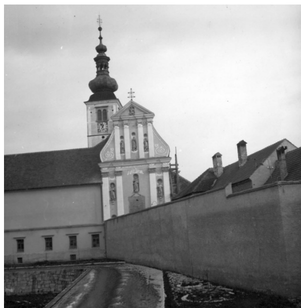
Slika 11 Lepoglava, župna crkva, pogled na zapadno pročelje nakon popravka, Vladimir Bradač, 1954.
