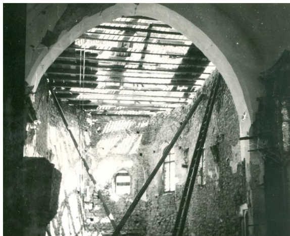
Slika 16 Očura, kapela sv. Jakova, pogled na svetište sa novim stropnim gredama, Greta Jurišić, 1952.
