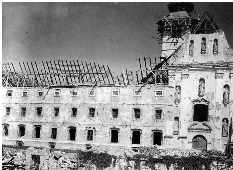
Slika 4 Lepoglava, nekadašnji samostan i župna crkva, pogled na zapadno pročelje oštećeno eksplozijom municije, Tihomil Stahuljak, 1945.
