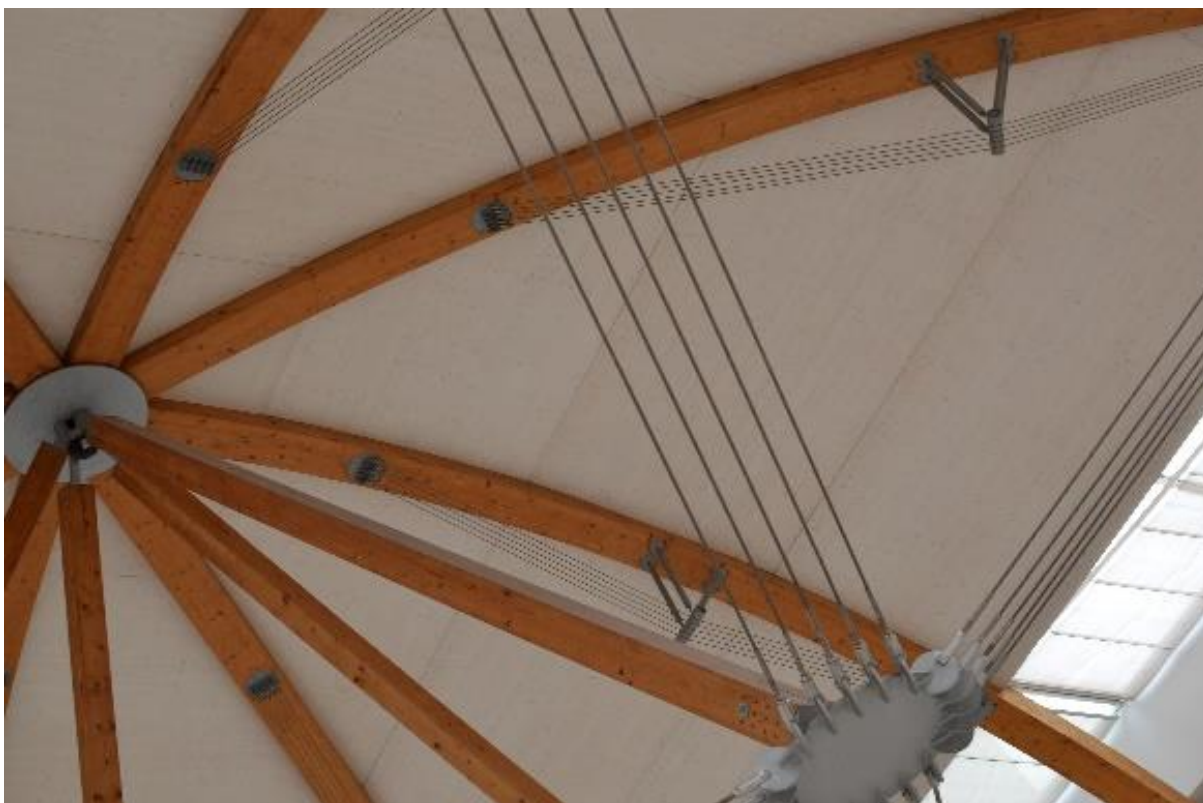
Kat. I. Sl. 40. Konstrukcija iznad molitvenog prostora u džamiji Behram-begove medrese (2016.)
