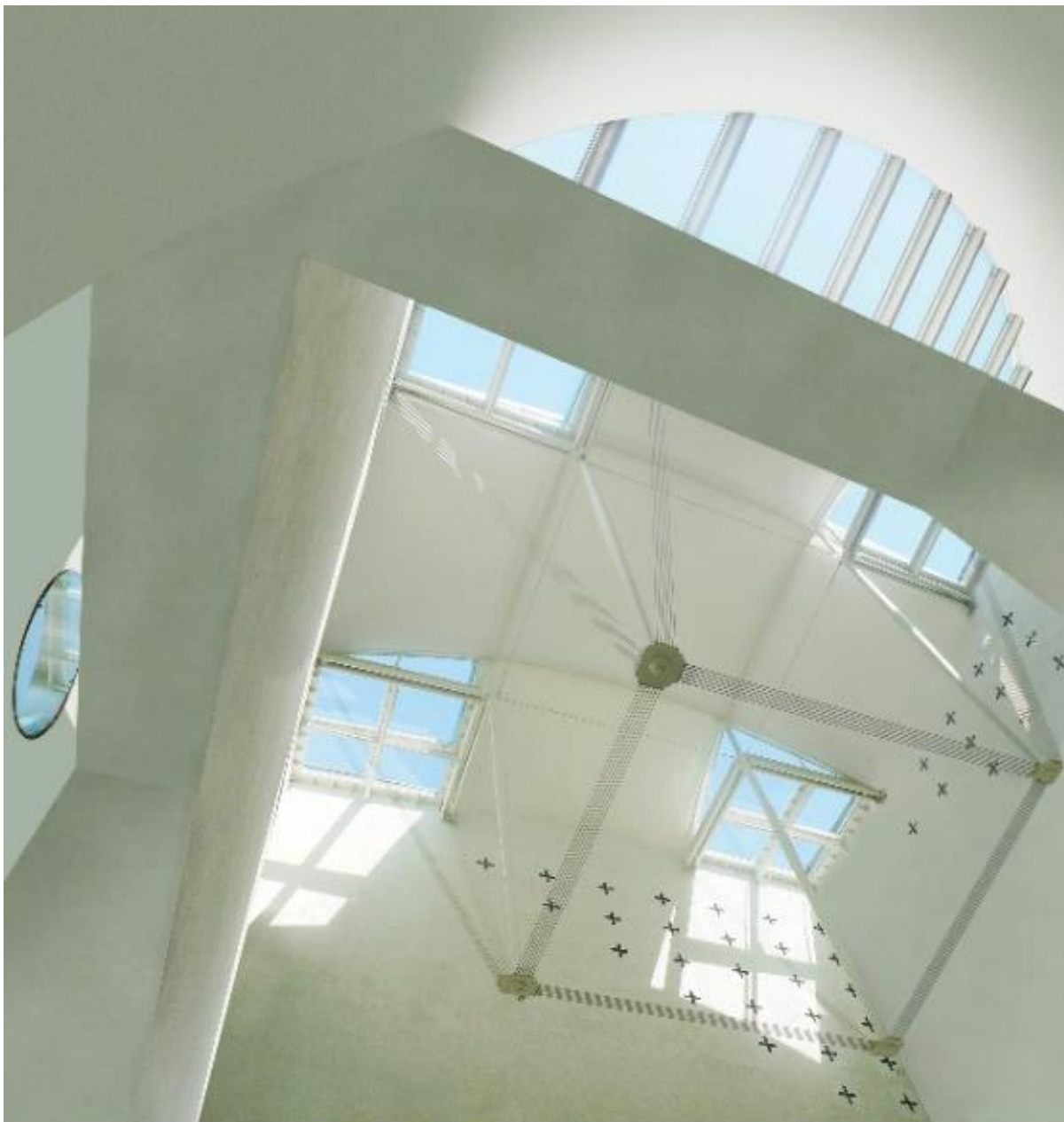
Kat. I. Sl. 34. Stropna konstrukcija u crkvi sv. Marka na Plehanu. (s. a.).
