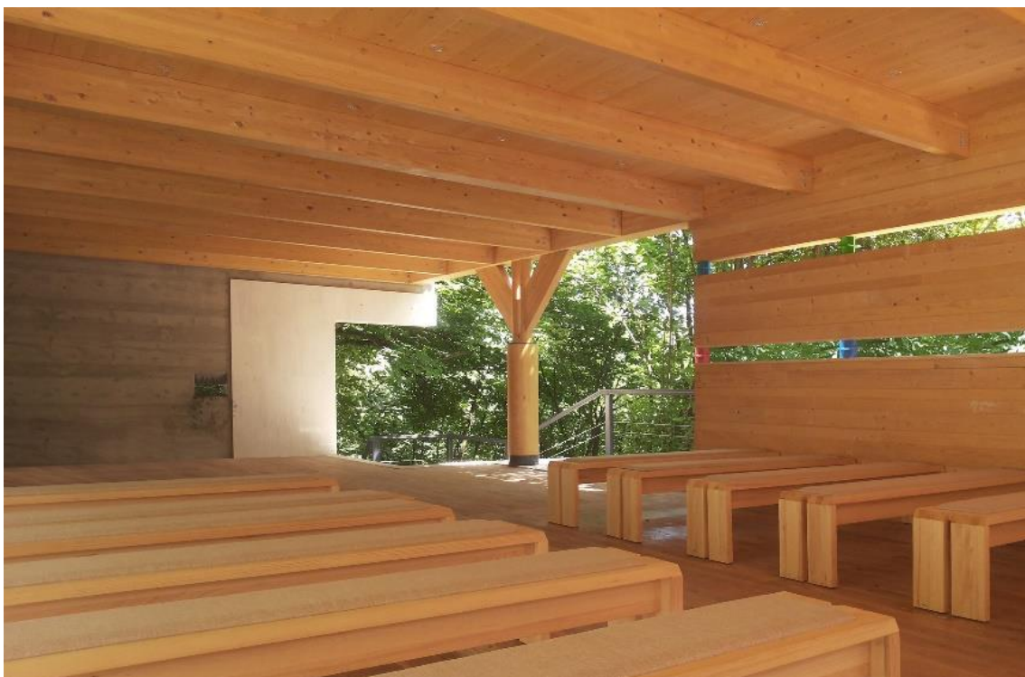
Kat. I. Sl. 64. Bočni zid od drvenih greda u crkvi sv. Ante na Svetoj Gori - Kalvariji u Malom Mošunju, Vitez. (s. a.).
