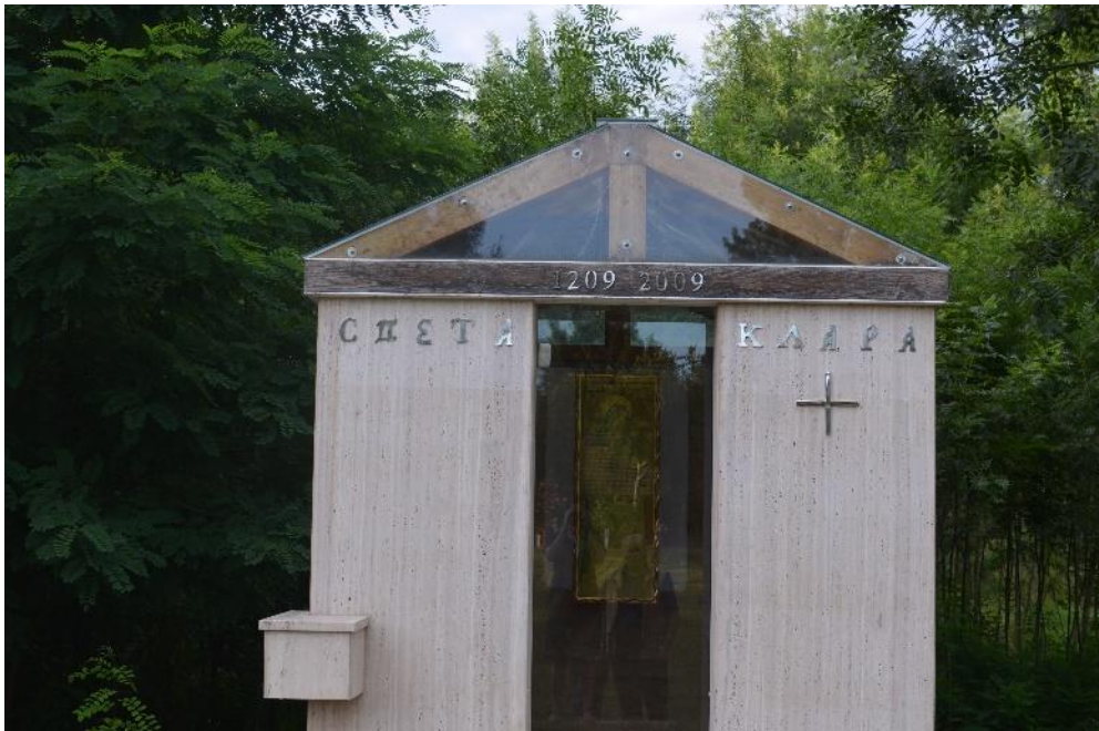
Kat. I. Sl. 58. Pročelje kapelice Sv. Klare u Svilaju, (2016.).
