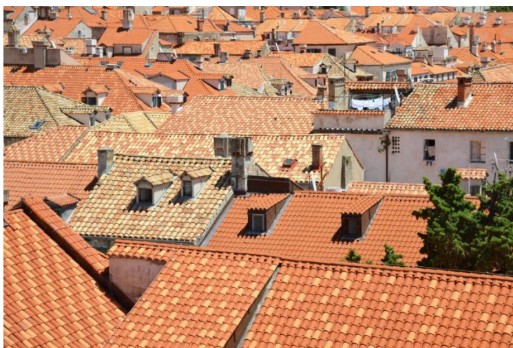
Slika 57. Krovovi nakon obnove
