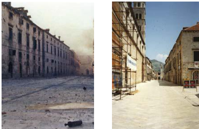
Slika 51. Pločnik na Stradunu prije i nakon obnove
