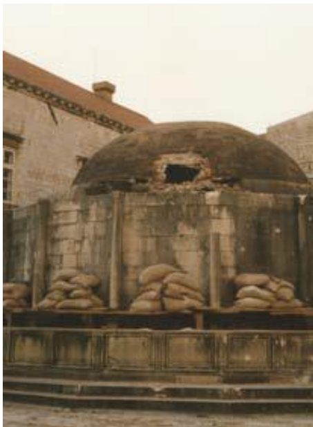
Slika 46. Oštećena Velika Onofrijeva fontana
