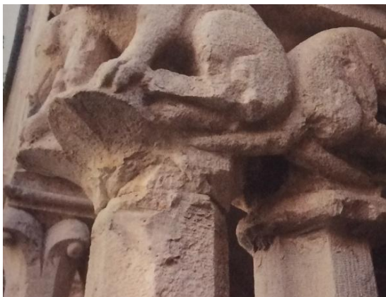
Slika 31. Oštećeni kapiteli
