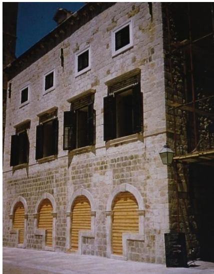
Slika 45. Palača u Ulici od Sigurate 1 (Palača Festivala) 1996.-1997., obnova konstrukcije i pročelja
