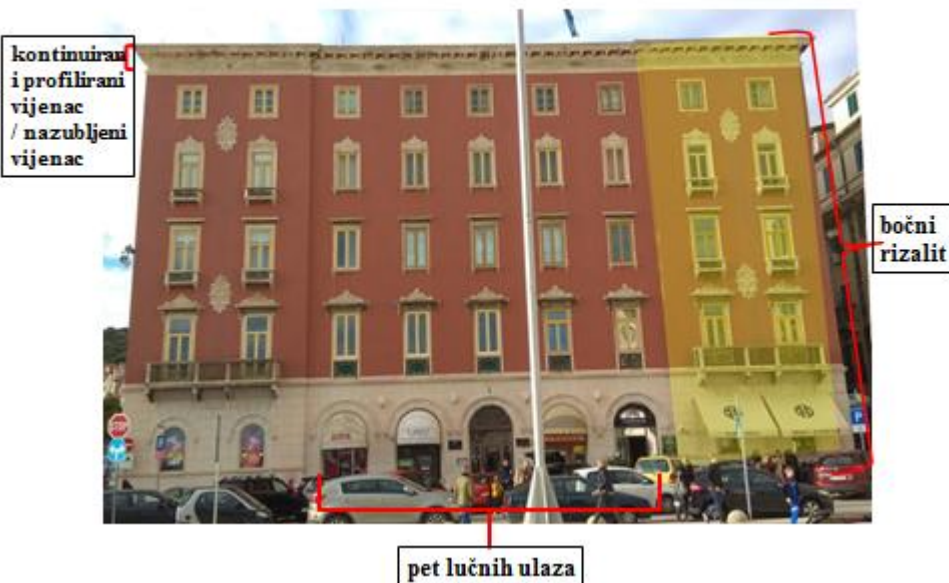
Foto 63. Antonio Bajamonti, Palača Bajamonti-Dešković, istoč. pročelje Grupa VI izlaže o formalnim karakteristikama istočnog pročelja palače Bajamonti-Dešković. Na prezentaciji su animacijom istaknuti elementi raščlambe pročelja koje učenici zajedno s grupom VI analiziraju na satu.
