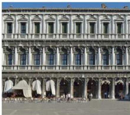
Nove prokurative (Procuratie Nuove), detalj fasade, Trg svetog Marka, Venecija, 1584.-1640.
