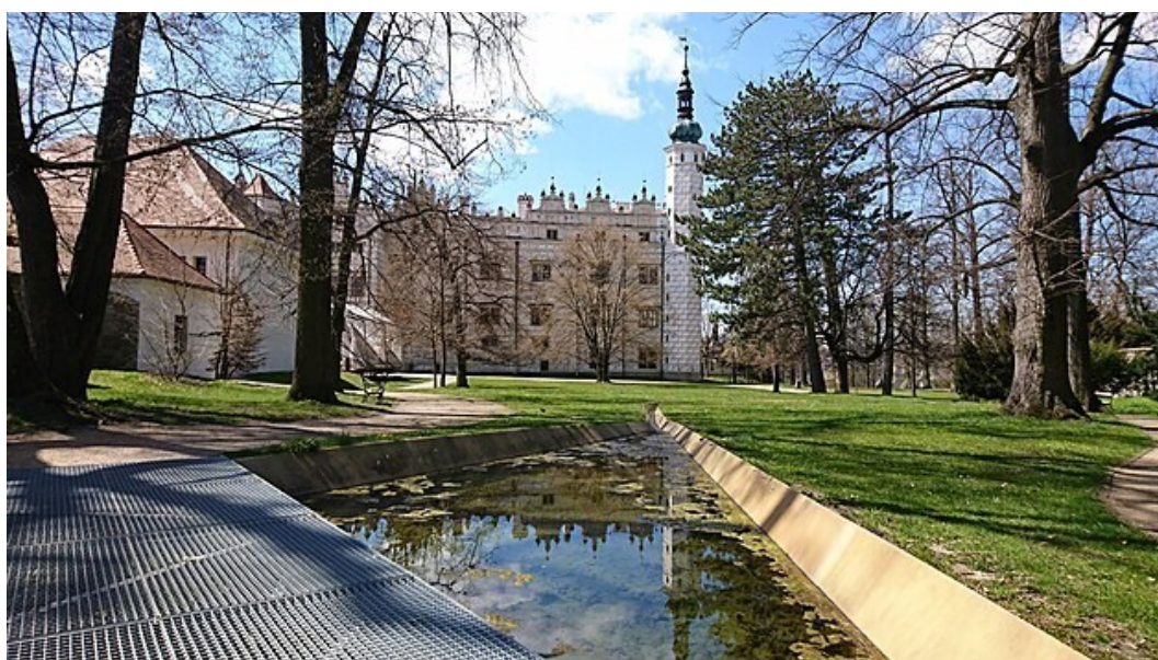
Slika 46. Korito potoka izrađeno od stakloplastike
