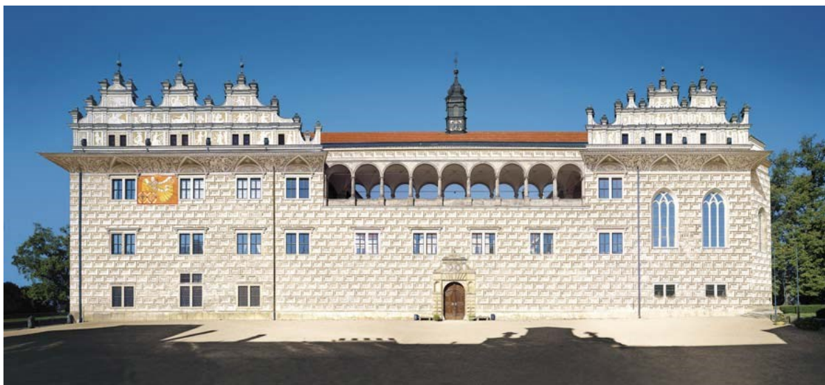
Slika 14. Južno pročelje dvorca
