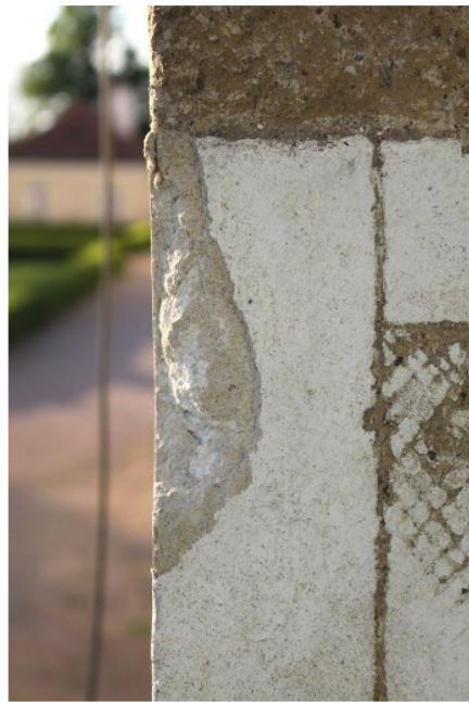
Slika 33. Mehaničko oštećenje
