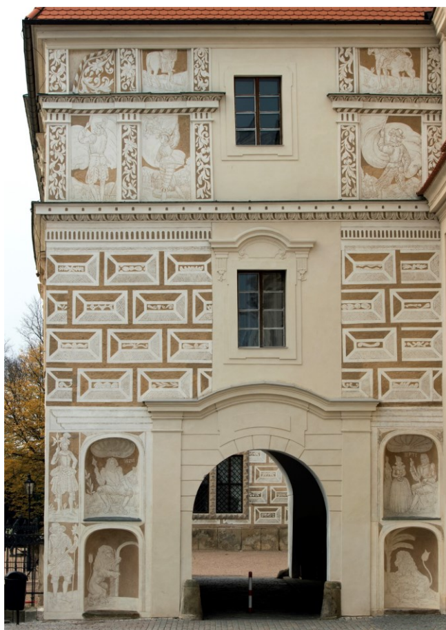
Slika 36. Jugoistočno pročelje ulaznog tornja pivovare
