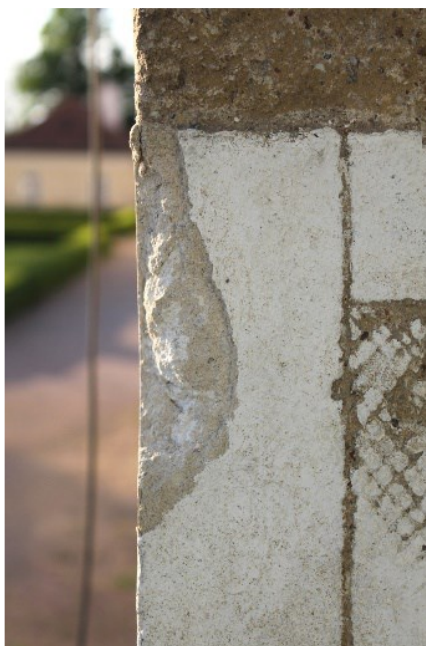
Slika 33. Mehaničko oštećenje
