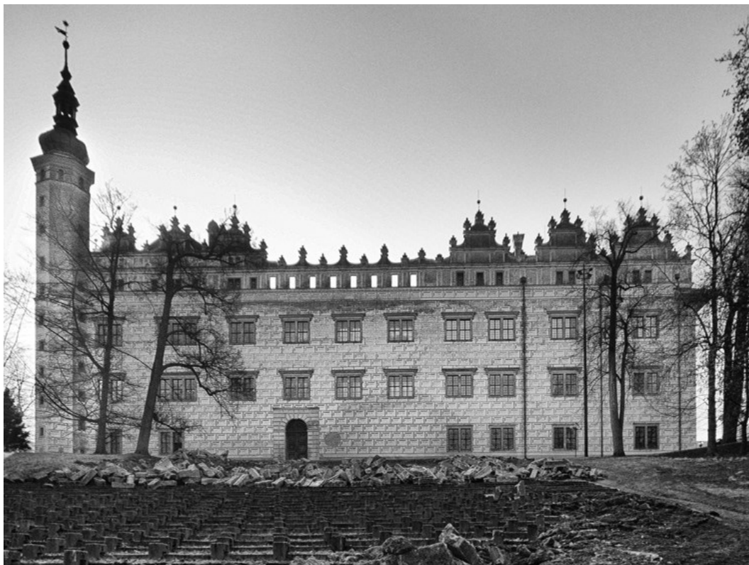
Slika 15. Sjeverno pročelje dvorca
