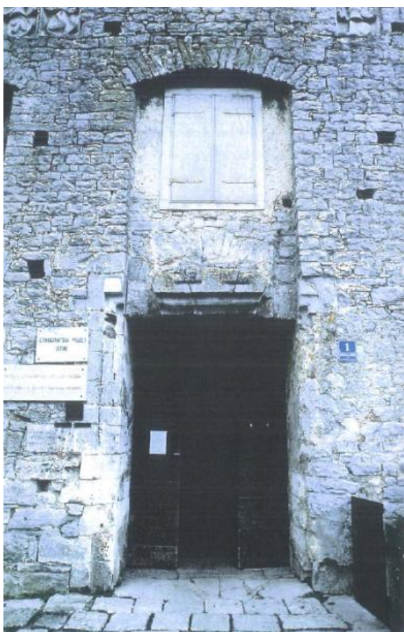
Slika 29. Pazinski kaštel, kolni ulaz prije restauracije
