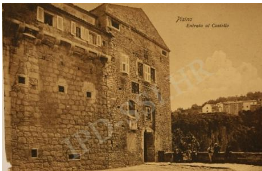
Slika 27. Pazinski kaštel, stanje prije restauracija
