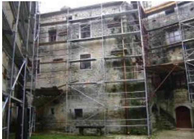
Slike 32. i 33. fotografije s restauracije unutarnjih pročelja, 2010. godina
