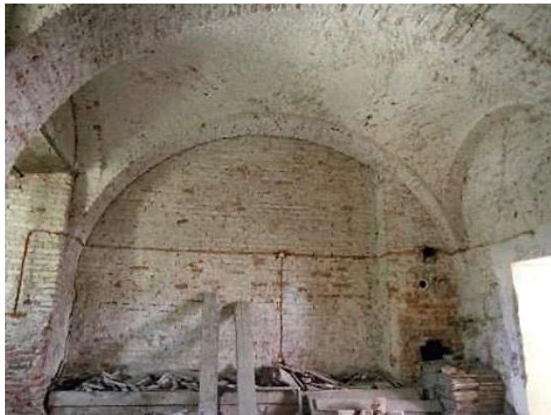
Slika 20. Češki svod, prvi kat jugozapadnog krila
