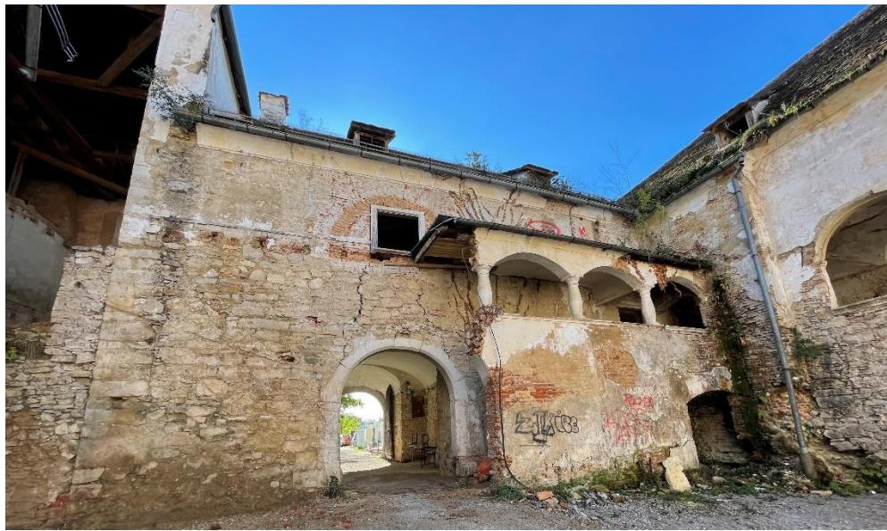
Slika 27. Oštećenja jugoistočnog dvorišnog pročelja
