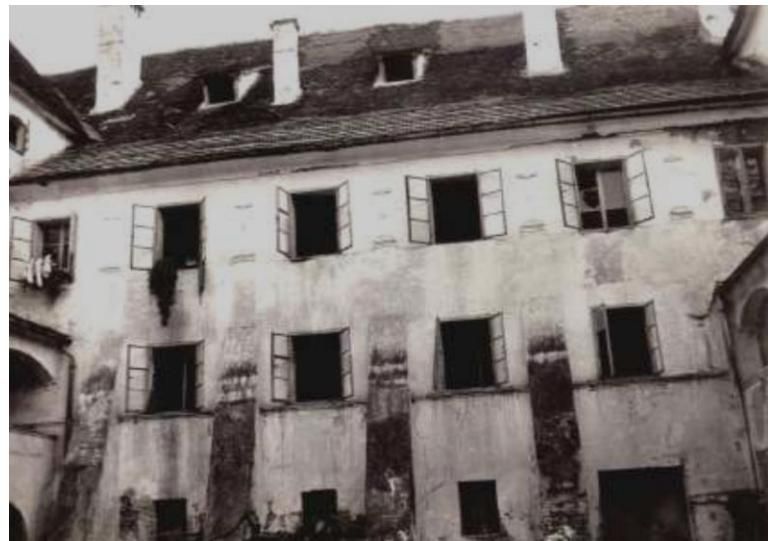
Slika 22. Dvorišno pročelje sjeveroistočnog krila, zazidane arkade umjesto kojih su probijeni novi prozorski otvori,
