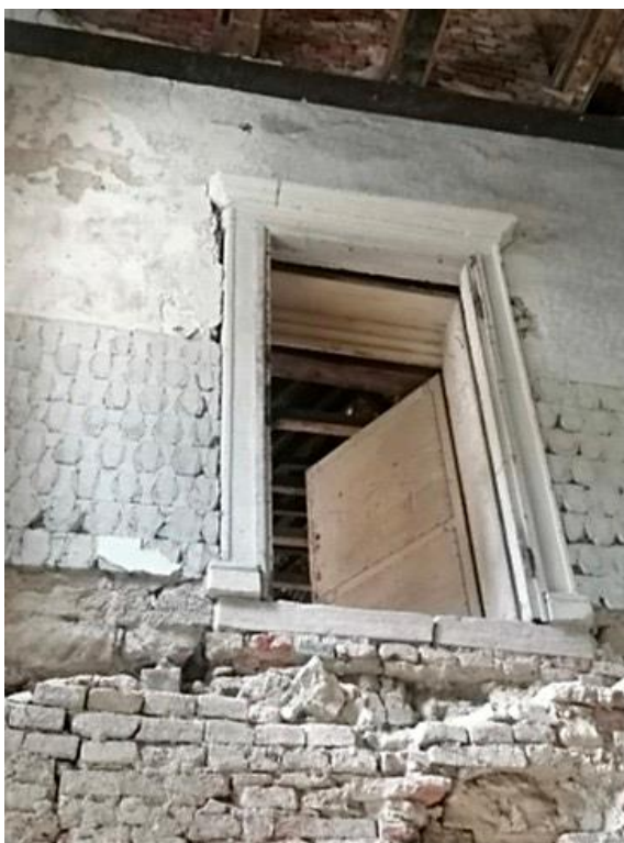
Slika 18. Kameni okvir vrata iz treće faze izgradnje, sjeverozapadno krilo
