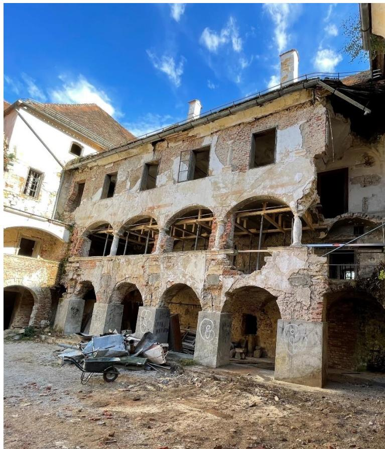
Slika 26. Oštećenje trijema, sjeveroistočno pročelje
