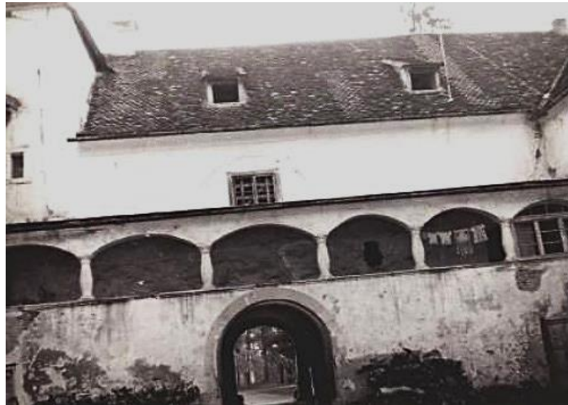
Slika 21. Dvorišno pročelje jugoistočnog krila sa izgrađenim parapetnim zidom nad arkadama prvog kata, 1948., fototeka Konzervatorskog odijela u Zagrebu
