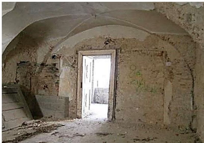
Slika 17. Bačvasti svod sa spojenim susvodnicama, prvi kat sjeveroistočnog krila
