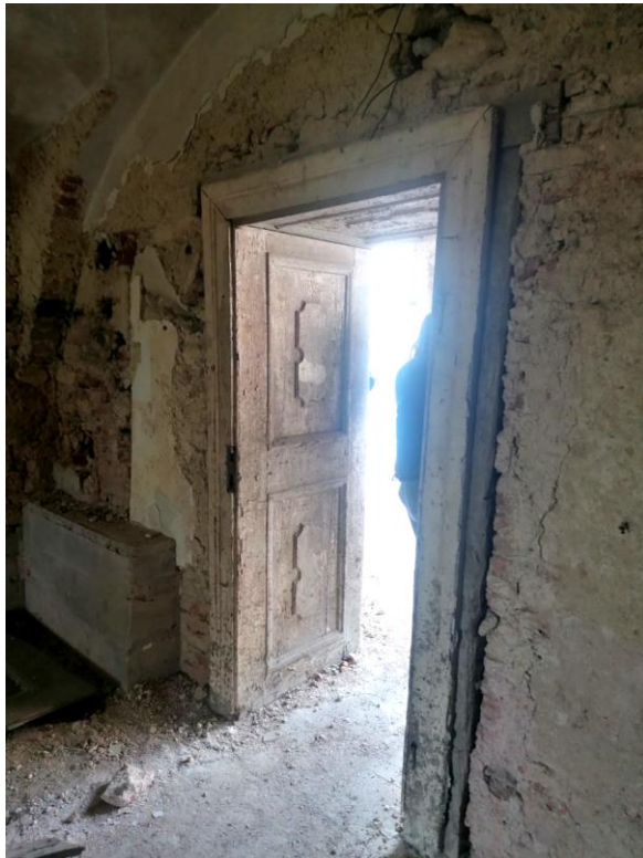
Slika 28. Drveni okvir vrata iz 18. stoljeća, sjeveroistočno krilo
