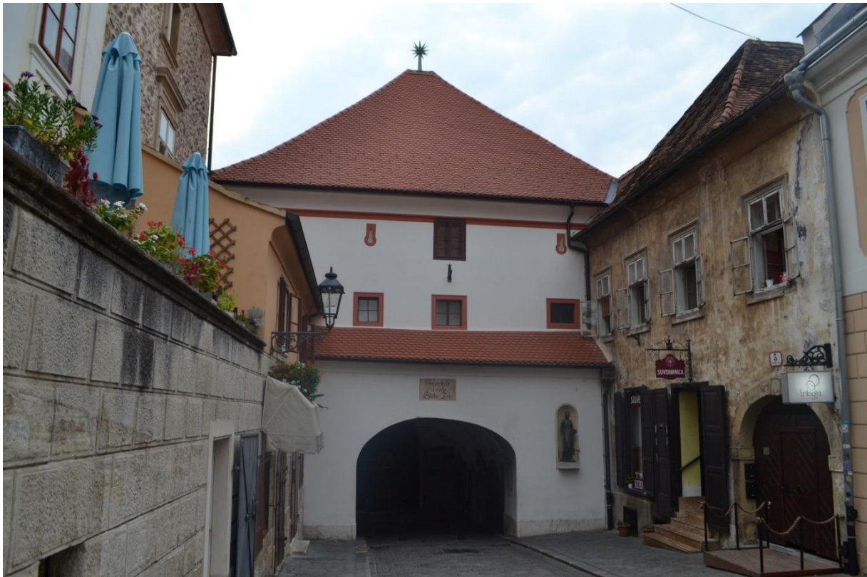
Slika 20. Zapadno pročelje Kamenitih vrata nakon obnove 2018. godine, 2019., snimila: R.T.
