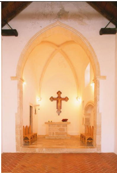
sl.48. Svetište prije posljednjih obnova
