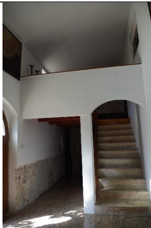
sl.25. Stepenice u hodniku samostanske zgrade
