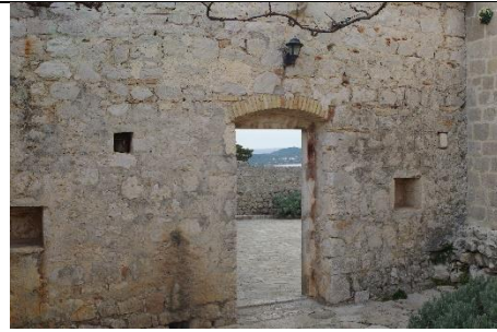
sl.8. Ulazna vrata u samostansko dvorište
