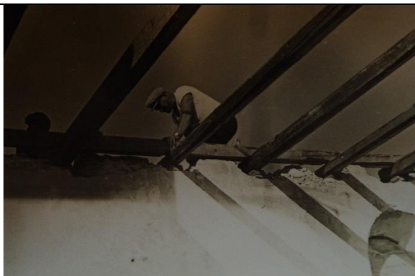
sl.27. Postavljanje krovišta
