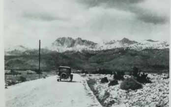
Cesta iz Obrova preko Malog Malana u Liku, kod njom Taluših Greda
